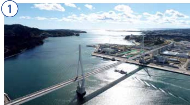
1 三陸沿岸道路「気仙沼港IC～唐桑半島IC」、 「気仙沼湾横断橋」が開通
