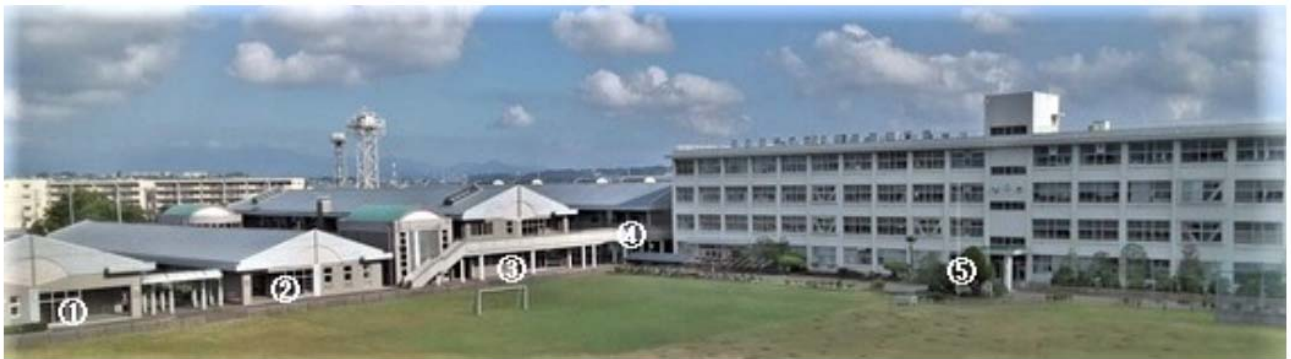
全景（南東側から撮影）
