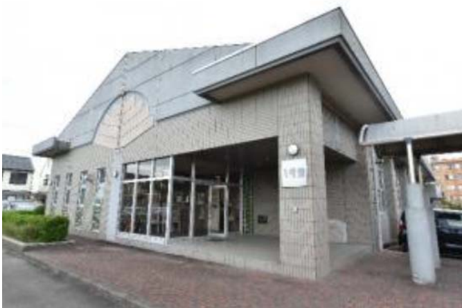
① 1号館実習棟（運動場側から撮影）
