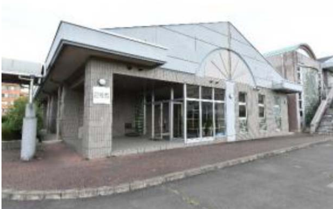
② 2号館実習棟（運動場側から撮影）
