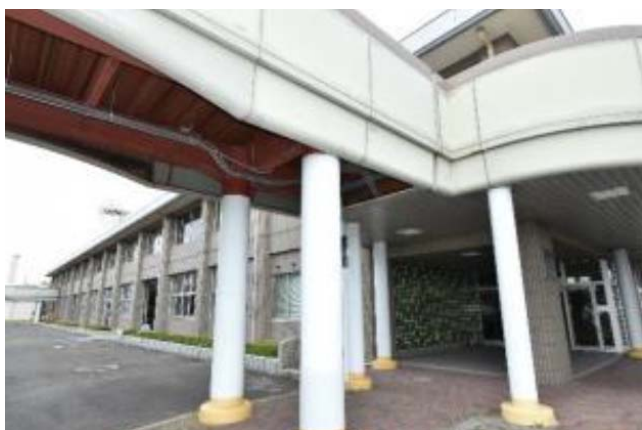
④ 4号館実習棟（運動場側から撮影）
