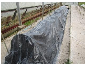
写真-2 ビニールシート被覆後
