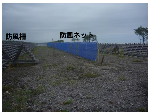
写真－4 防風柵・防風ネット設置状況
