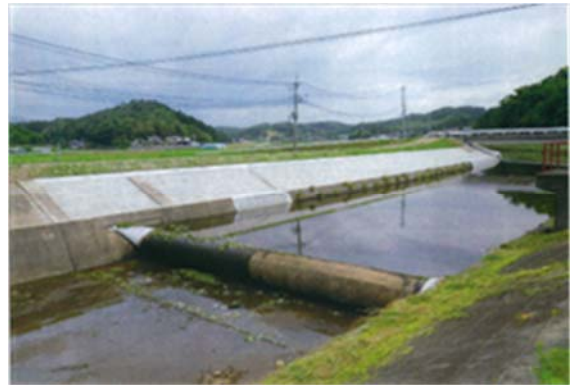
▲平成 25 年 7 月 25 日 本復旧完了
