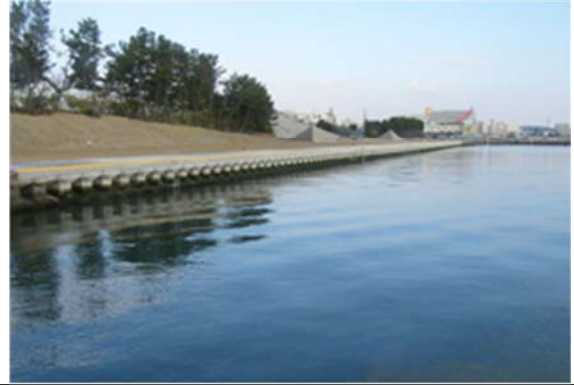
▲平成 26 年 2 月 28 日 本復旧完了
