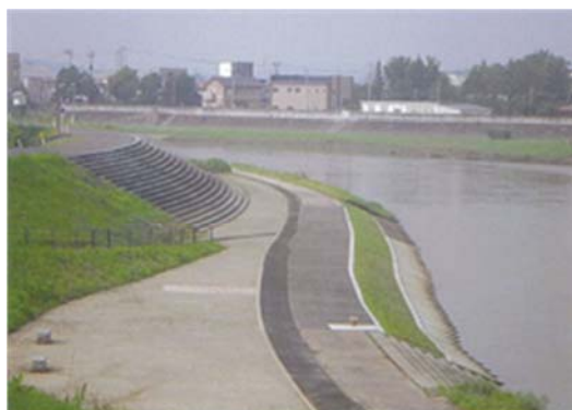
▲平成 25 年 8 月 21 日 本復旧完了
