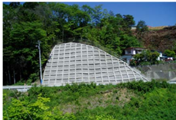
▲平成 25 年 5 月 20 日 吹付法枠工完了
