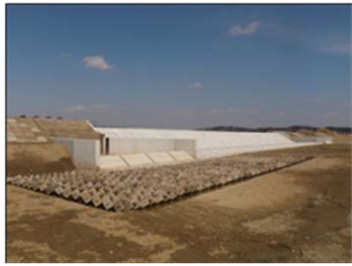
▲平成26年3月25日 本復旧完了
