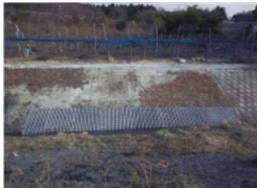
▲平成 25 年 7 月 3 日 本復旧完了
