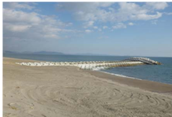
▲平成 25 年 12 月 11 日 本復旧完成
