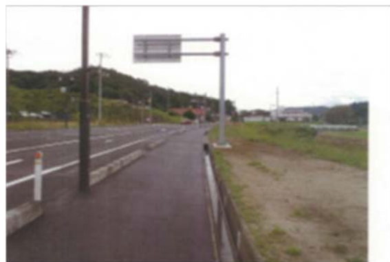
▲平成 25 年 6 月 28 日 本復旧完了
