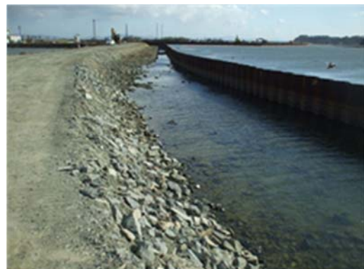
▲平成 26 年 3 月 25 日 本復旧完了
