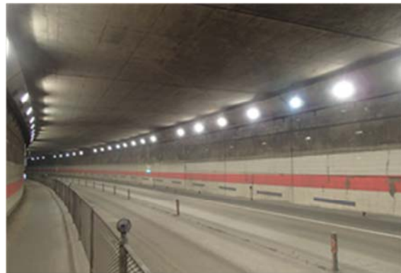
▲平成 25 年 12 月 13 日 本復旧完了 トンネル照明〔セラミックメタルハライド灯〕
