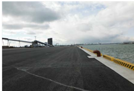
▲平成 26 年 3 月 28 日 一部荷捌地復旧完了
