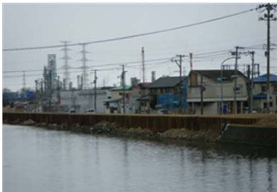
▲砂押川 多賀城市桜木地内 被災状況
