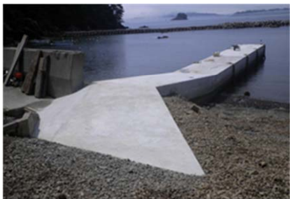
▲平成 26 年 2 月 3 日 完成 唐桑海岸 栃浜地区海岸 突堤(1)
