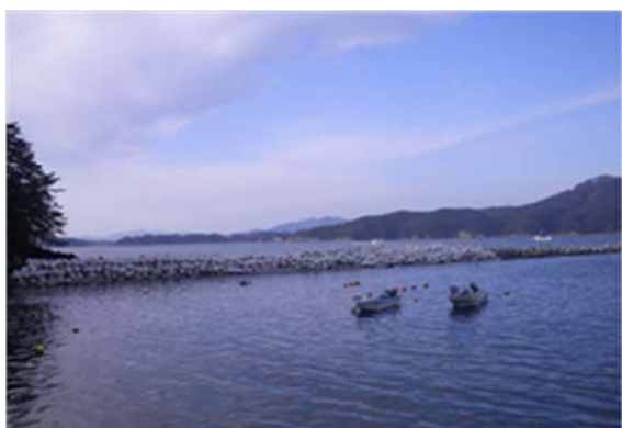
▲平成 26 年 2 月 3 日 完成 唐桑海岸 栃浜地区海岸 突堤(2)
