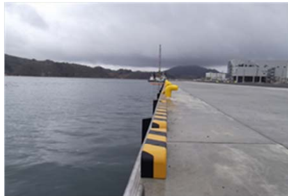
▲本復旧完了 平成 25 年 12 月
