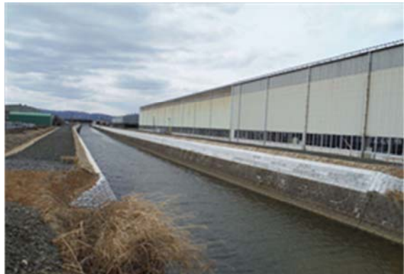
▲平成 26 年 3 月 26 日 本復旧完了
