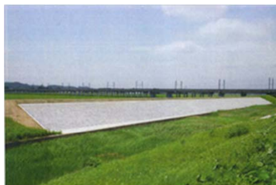
▲平成 25 年 7 月 25 日 本復旧完了
