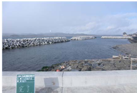
▲平成 26 年 3 月 28 日 本復旧完了
