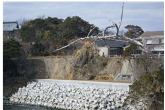
▲平成 26 年 3 月 24 日 本復旧完了
