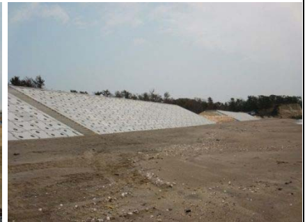
災害復旧工事進捗状況 （菖蒲田地区海岸 H26.2）
