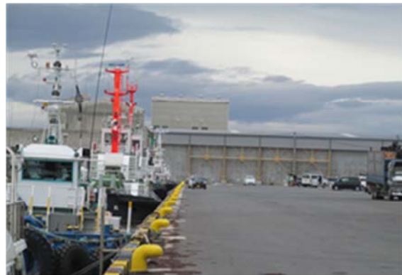
▲本復旧完了 平成 25 年 12 月 27 日
