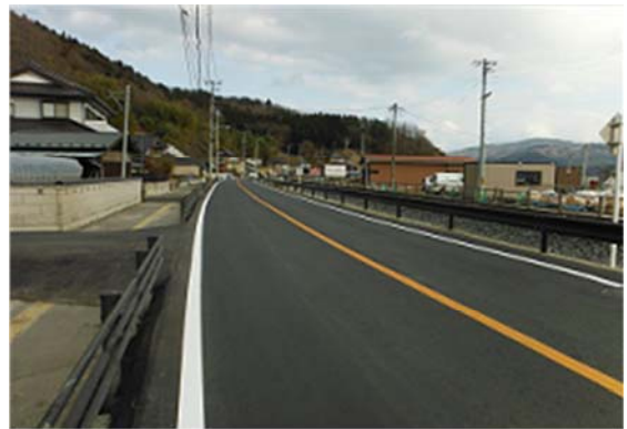
▲平成 26 年 2 月 14 日 本復旧完了
