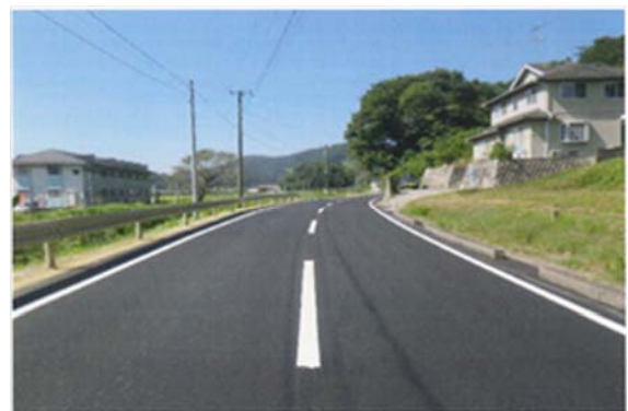
▲平成25年9月26日 本復旧完了
