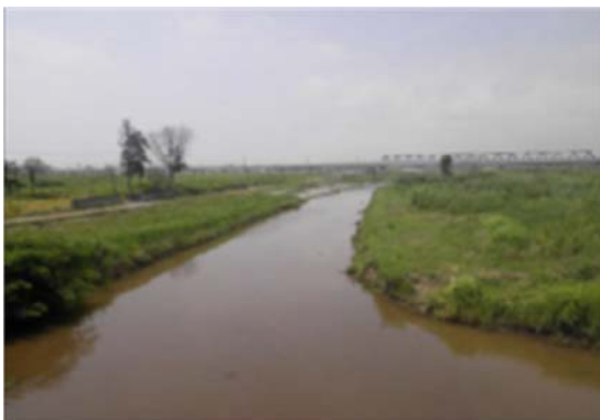
▲川内沢川（放水路） 名取市下増田地内 放水路掘削築堤・護岸工事
