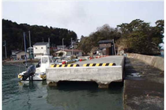
▲平成 26 年 3 月 28 日 本復旧完了
