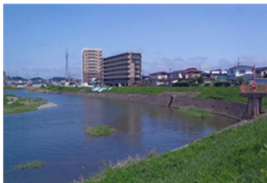
▲七北田川 仙台市泉区八乙女地内 被災状況
