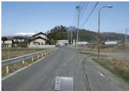
平家川 橋梁下部工・護岸 着工前
