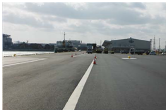
▲平成 26 年 3 月 28 日 本復旧完了
