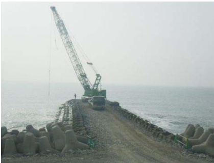
災害復旧工事進捗状況 （大曲地区海岸 H26.2）
