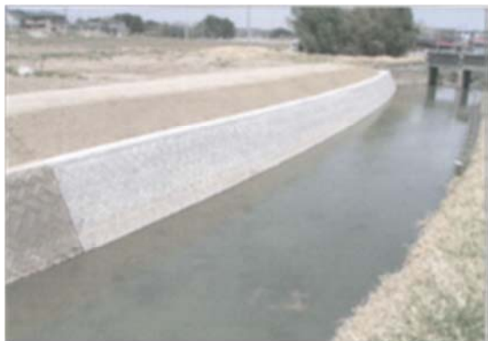
▲平成 26 年 3 月 20 日 本復旧完了
