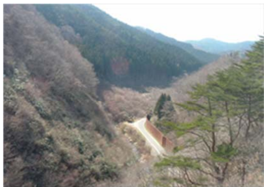
▲ 弘川ダム 南三陸町歌津字弘川地内 ダム本体工事 着手 (H21.3月)
