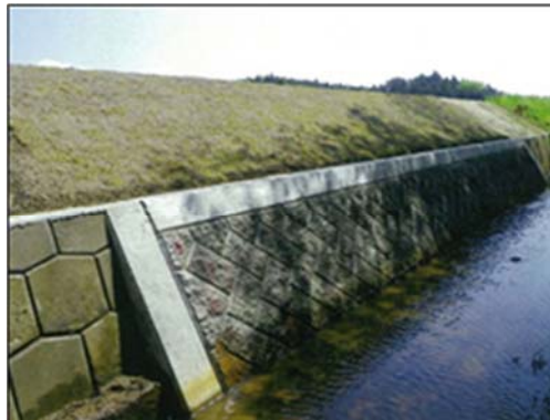
▲平成25年5月27日 本復旧完了
