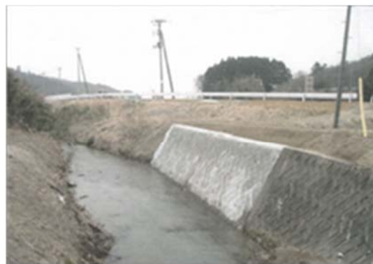
▲平成 26 年 3 月 20 日 本復旧完了
