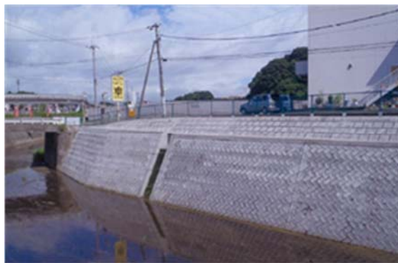
▲平成 25 年 7 月 18 日 本復旧完了
