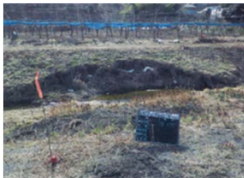
▲藤田川 宮城郡利府町春日地内被災状況
