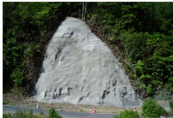
▲平成 25 年 5 月 30 日 吹付工完了
