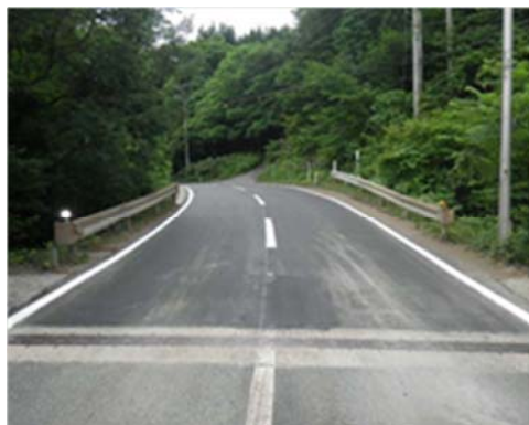
▲平成 25 年 9 月 19 日 本復旧完了
