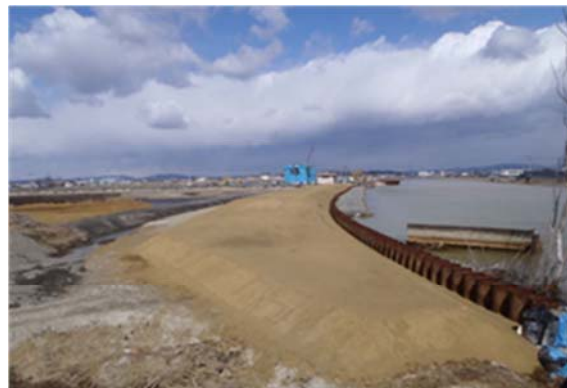
▲平成 26 年 3 月 14 日 築堤盛土(暫定)完成
