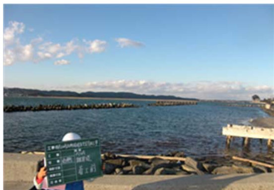
▲仙台塩釜港（塩釜港区） 代ヶ崎離岸堤
