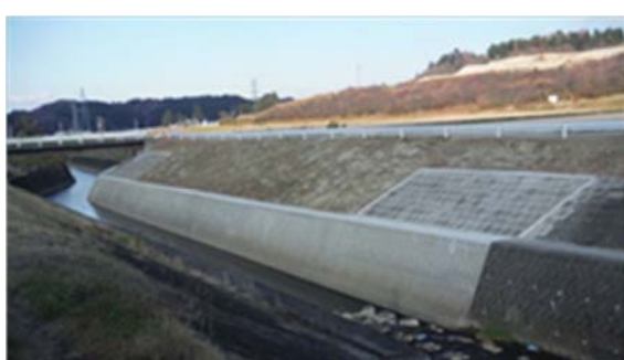
▲平成 26 年 3 月 20 日 本復旧完了
