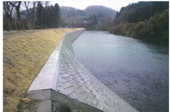
▲平成 26 年 3 月 20 日 本復旧完了
