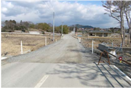
▲平成 24 年 3 月 2 日 着工 気仙沼市長崎地内 (大島)
