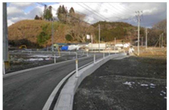
▲平成 26 年 2 月 12 日 本復旧完了
