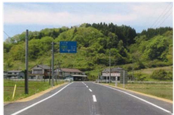
▲平成25年9月26日 本復旧完了
