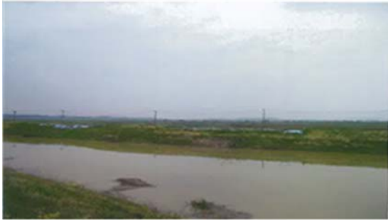
▲鶴田川 宮城郡松島町幡谷地内 被災状況
