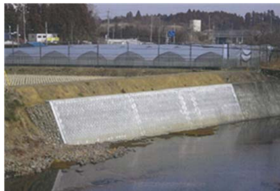
▲平成 26 年 2 月 21 日 本復旧完了
