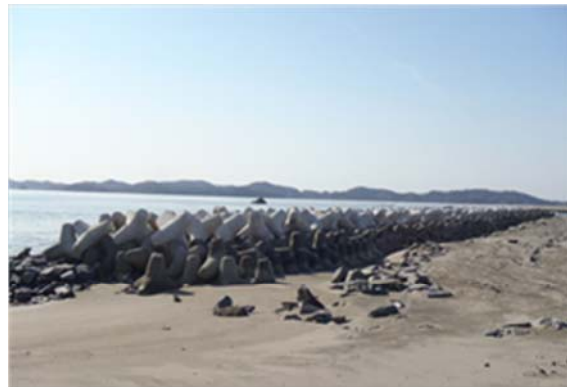
▲平成 26 年 3 月 13 日 本復旧完成
