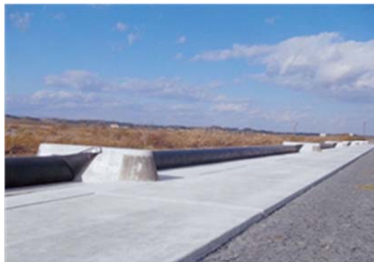
▲平成 25 年 11 月 29 日 本復旧完了
