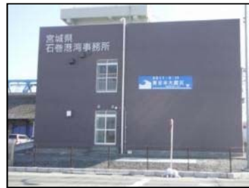
③ 津波浸水表示板設置事例
