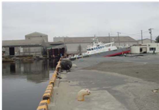
▲潮見岸壁・荷捌地被災状況 平成 23 年 3 月 15 日
