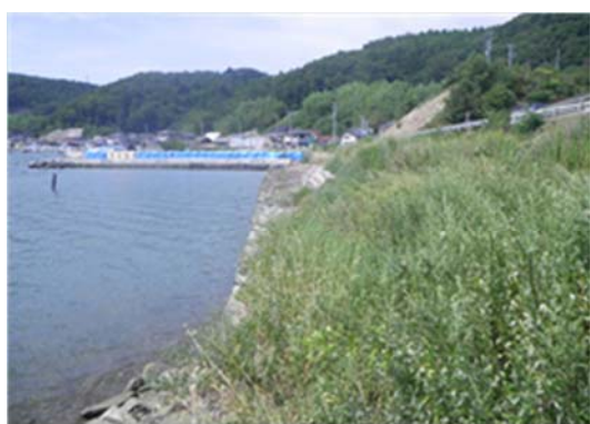
▲平成 24 年 8 月 9 日着工 折立海岸災害復旧工事 石巻市沢田地内
