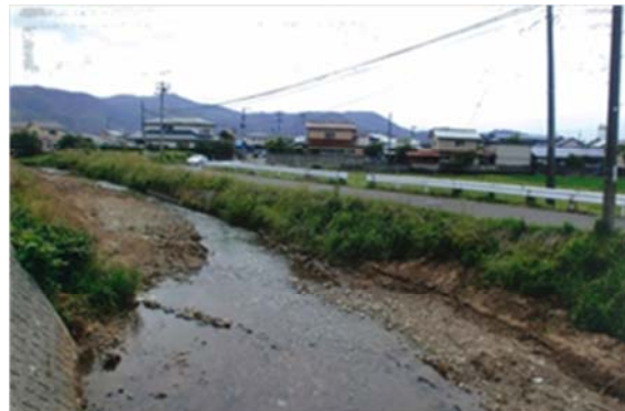
平成 26 年 1 月 29 日 河道掘削完了
