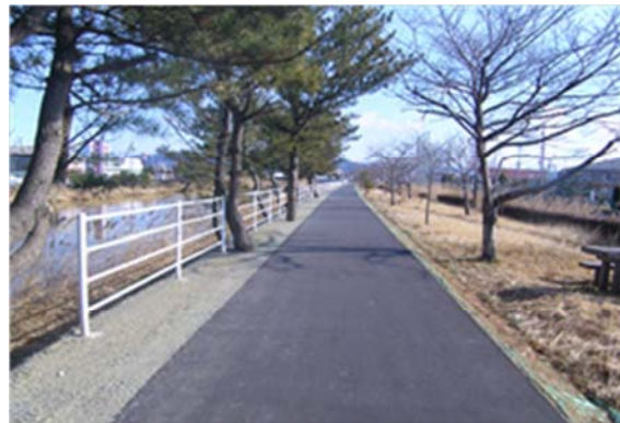
▲平成 26 年 2 月 25 日 本復旧完成
