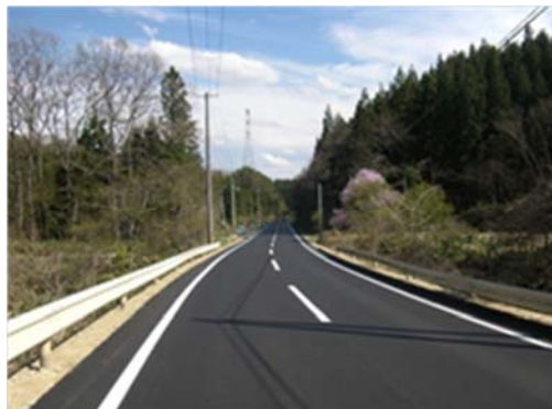
▲平成 25 年 5 月 20 日 本復旧完了
