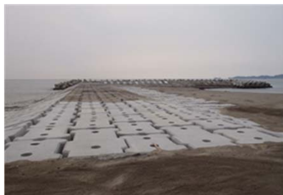
▲平成 26 年 3 月 13 日 本復旧完成
