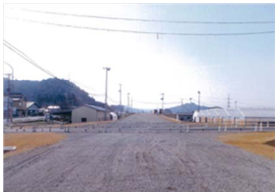
▲（国）398号 栗原市一迫新御崎前地内 宮前交通安全施設整備事業
