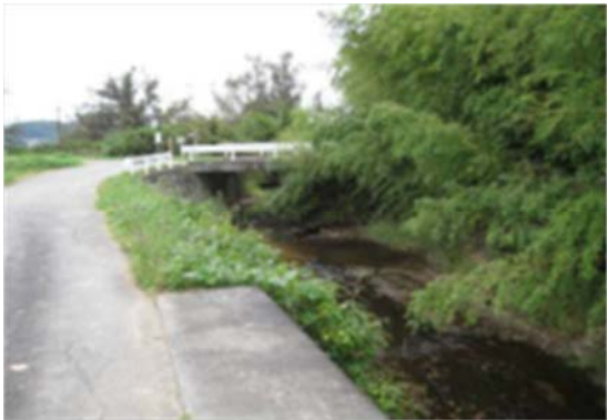
▲太田川河川改修事業 川下田橋架換工事 栗原市築館太田地内
