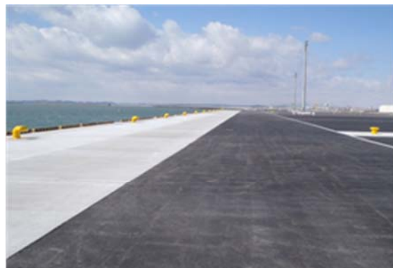
▲本復旧完了 平成 26 年 1 月 31 日
