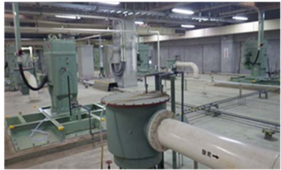
▲平成 25 年 12 月 10 日完成状況
