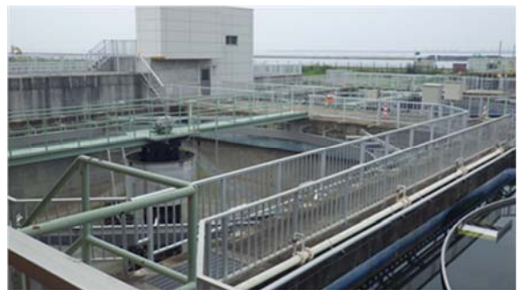
▲平成 26 年 3 月 26 日完成状況
