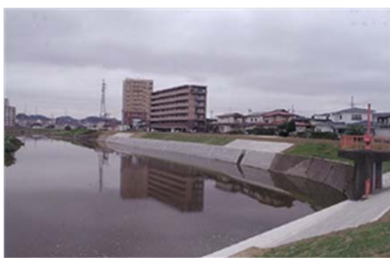
▲平成 25 年 7 月 18 日 本復旧完了
