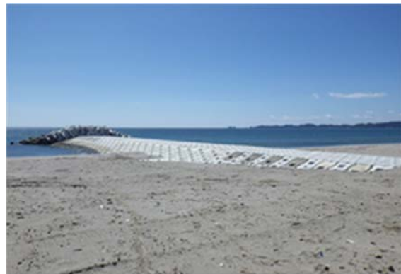
▲平成 25 年 12 月 11 日 本復旧完成
