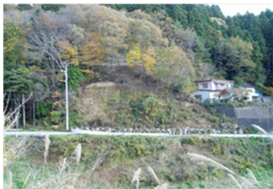
▲(一) 清水浜志津川港線 南三陸町志津川字阿曾地内 道路法面被災状況
