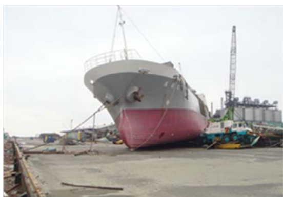
▲中島埠頭被災状況 平成 23 年 3 月 15 日
