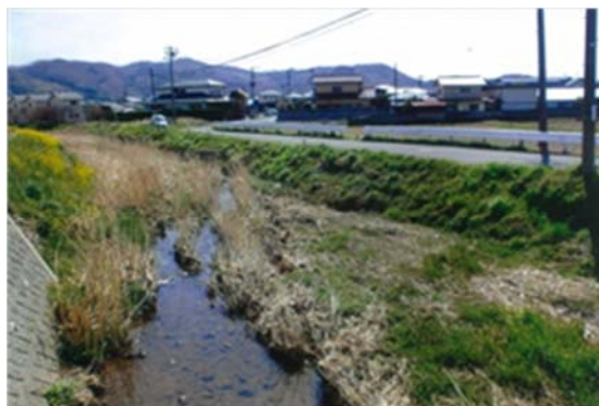
天津沢川河道土砂堆積状況
