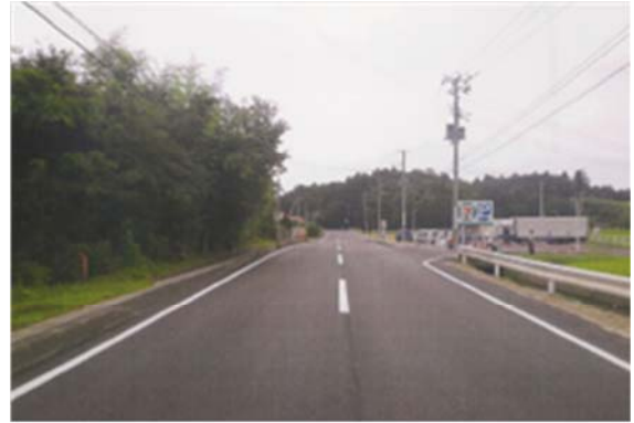
▲平成25年12月20日 本復旧完了
