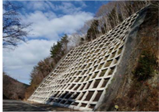
▲平成 25 年 12 月 11 日 本復旧完了
