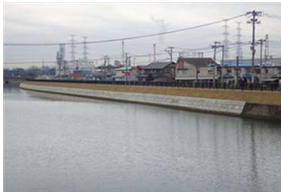
▲平成 25 年 12 月 20 日 本復旧完了
