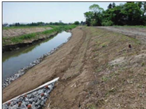
▲平成25年5月27日 本復旧完了
