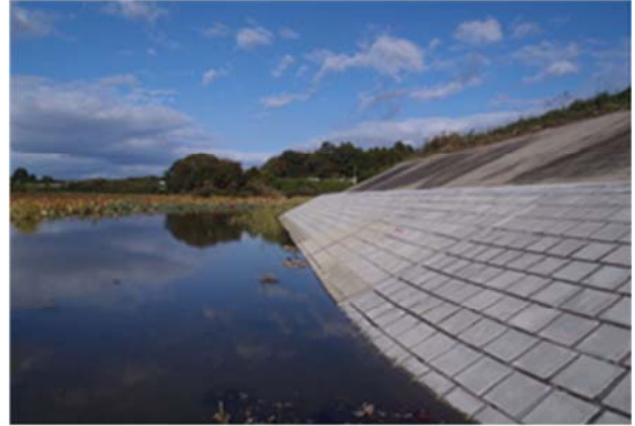
平成 24 年 10 月 24 日 本復旧完了
