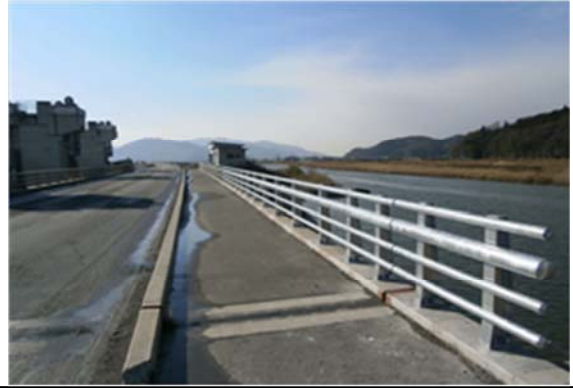
▲平成 25 年 7 月 2 日 本復旧完了
