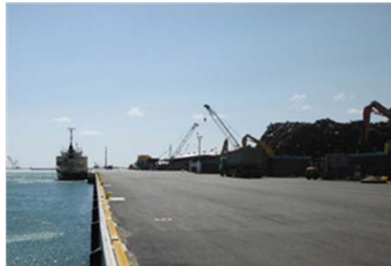
▲本復旧完了 平成 26 年 3 月 28 日
