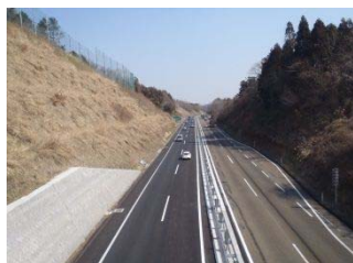
仙台松島道路（松島海岸 IC～松島北 IC）4車線化供用
