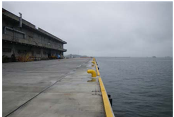
▲平成 25 年 7 月 8 日 本復旧完了
