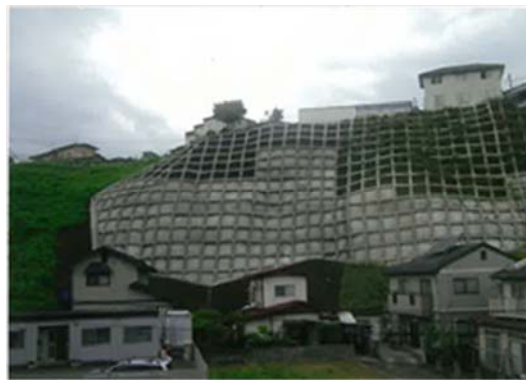
▲平成25年6月26日 本復旧完了
