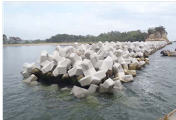
▲平成 25 年 8 月 25 日 本復旧完了
