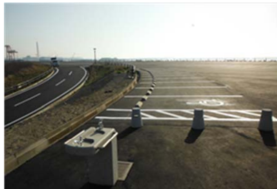
▲平成 25 年 8 月 26 日 本復旧完了
