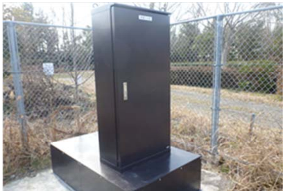
▲平成 25 年 12 月 6 日 本復旧完了
