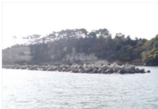
▲仙台塩釜港（塩釜港区） 石浜離岸堤
