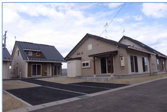
山元町新山下駅周辺地区第二期（完成）
