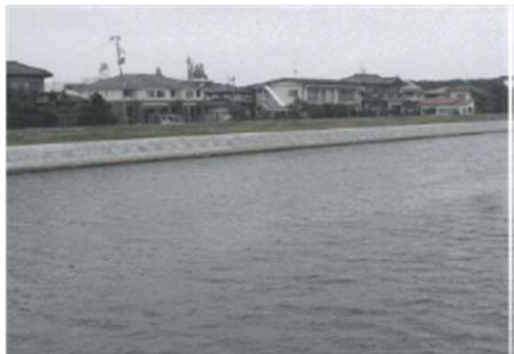
▲平成 25 年 9 月 30 日 本復旧完了
