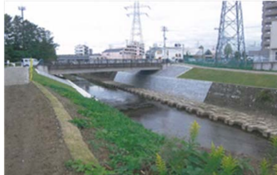
▲平成 26 年 2 月 21 日 本復旧完了
