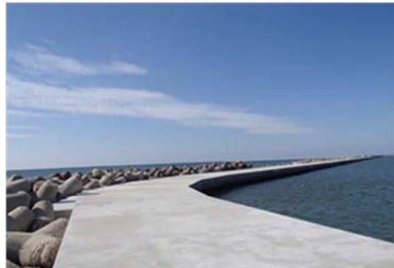
▲本復旧完了 平成 25 年 5 月 31 日
