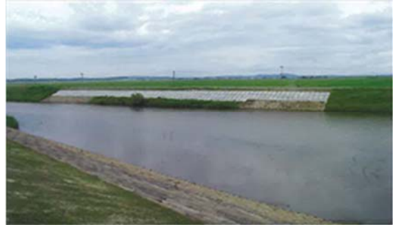
▲平成 25 年 6 月 26 日 本復旧完了
