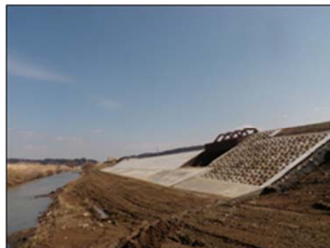
▲平成26年3月25日 本復旧完了
