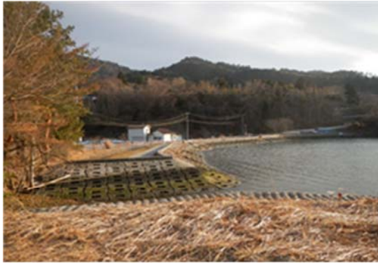
▲猪落海岸災害復旧工事 女川町猪落地内
