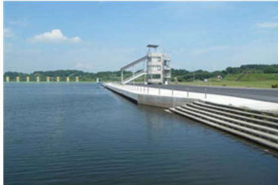
平成 24 年 7 月 20 日 本復旧完了
