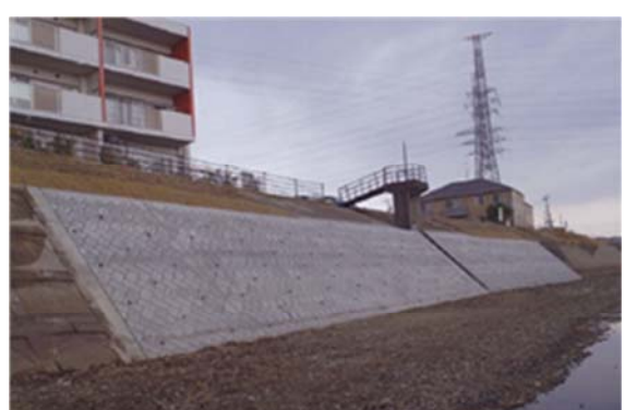
▲平成 25 年 7 月 18 日 本復旧完了
