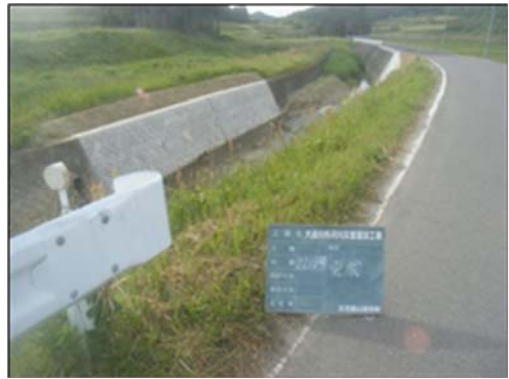
▲平成25年6月4日 本復旧完了
