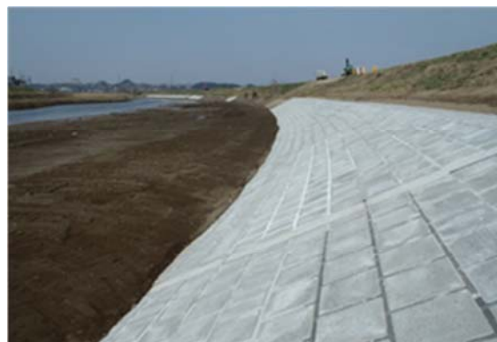
▲平成 25 年 4 月 16 日 本復旧完了
