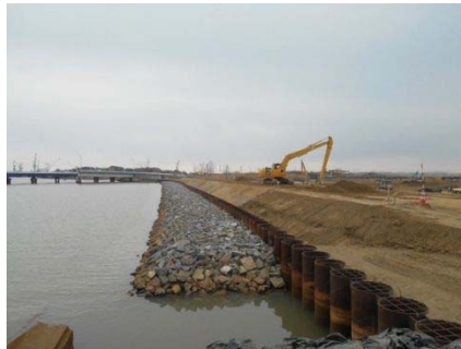
災害復旧工事進捗状況 （定川 H26.2）
