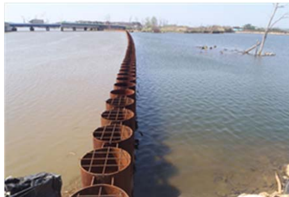
▲平成 25 年 5 月 22 日 鋼管杭打設完成
