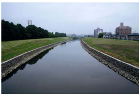
▲平成 25 年 7 月 24 日 本復旧完了
