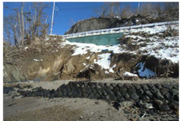
▲平成 25 年 6 月 31 日 本復旧完了
