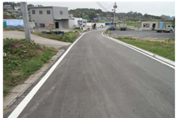
▲平成 25 年 6 月 3 日 本復旧完了
