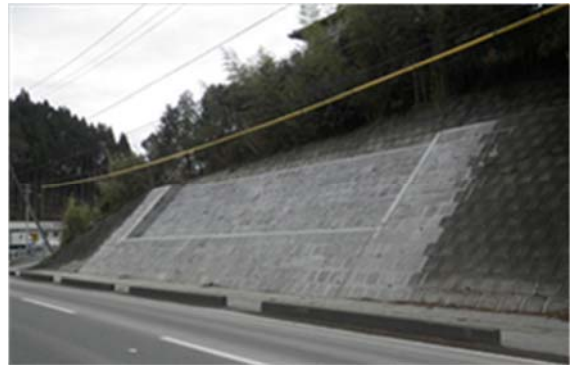
▲平成 26 年 2 月 12 日 本復旧完了
