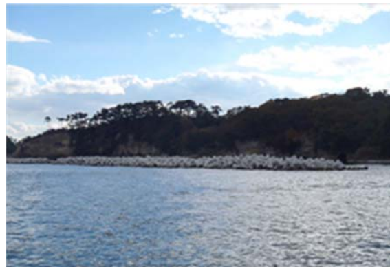
▲平成 26 年 3 月 28 日 本復旧完了
