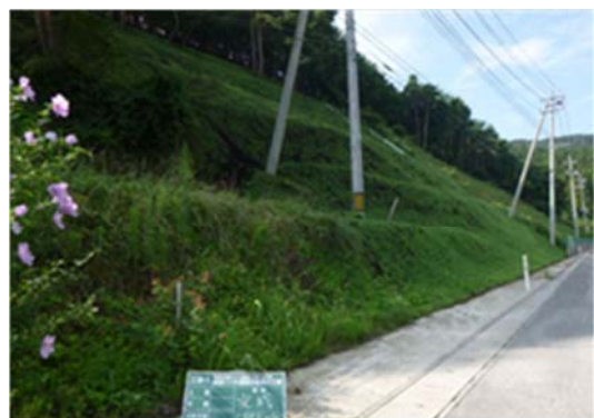
▲平成 26 年 1 月 8 日 本復旧完了
