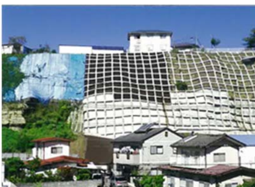
▲平成25年6月26日 本復旧完了
