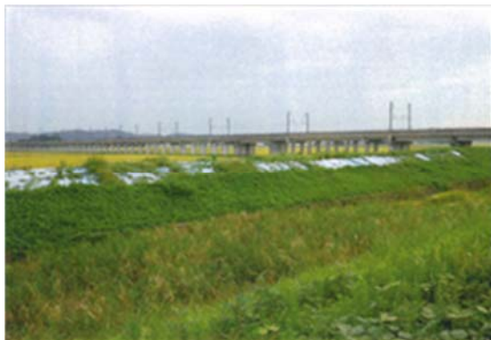
▲身洗川 黒川郡大和町落合地内外 被災状況
