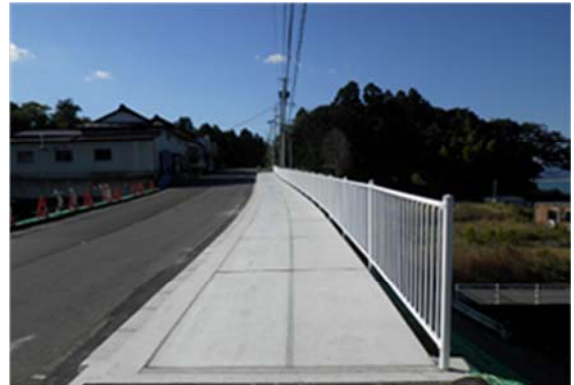
▲平成 25 年 10 月 15 日 本復旧完了
