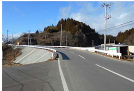
▲平成 25 年 12 月 20 日 本復旧完了
