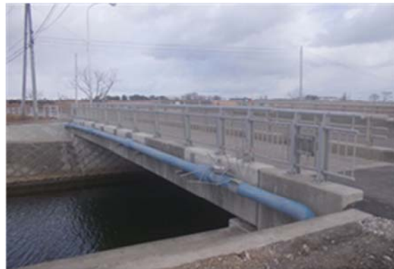
▲平成 26 年 2 月 19 日 本復旧完了
