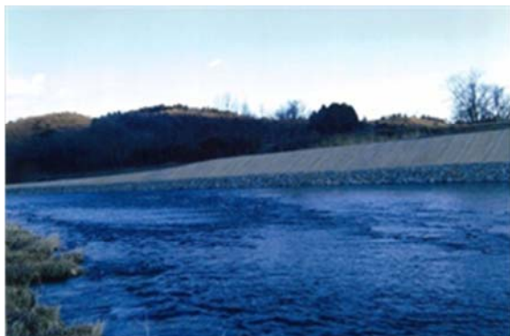
平成 26 年 1 月 29 日 白石川河岸復旧完了
