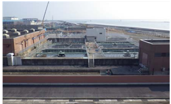
▲平成 26 年 3 月 26 日完成状況
