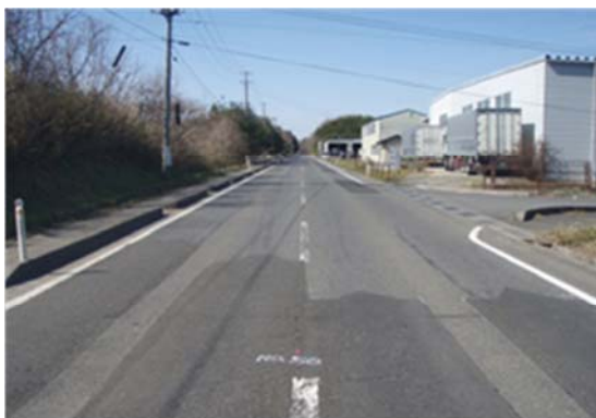
▲(主) 築館登米線 栗原市築館照越地内 照越舗装補修工事
