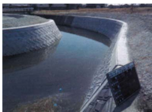
▲平成 25 年 7 月 3 日 本復旧完了
