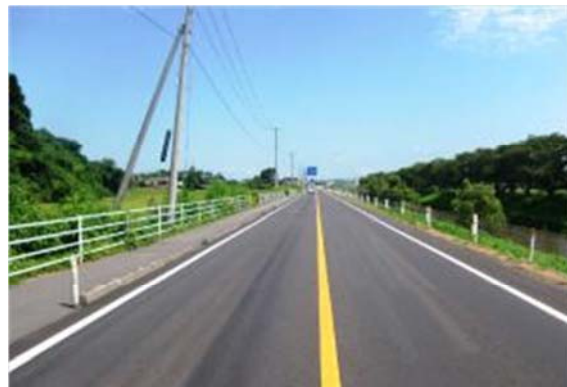
▲平成 25 年 8 月 29 日 本復旧完了
