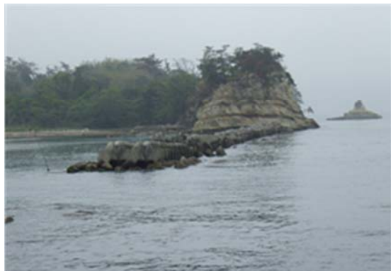
▲仙台塩釜港（塩釜港区） 寒風沢前浜離岸堤
