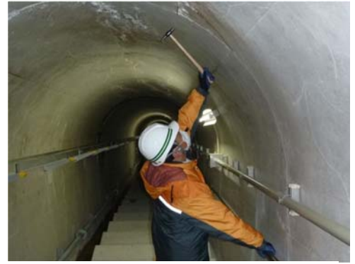
▲打音検査の状況
