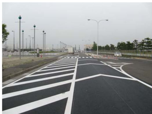
▲ふ頭5号線路工完了
