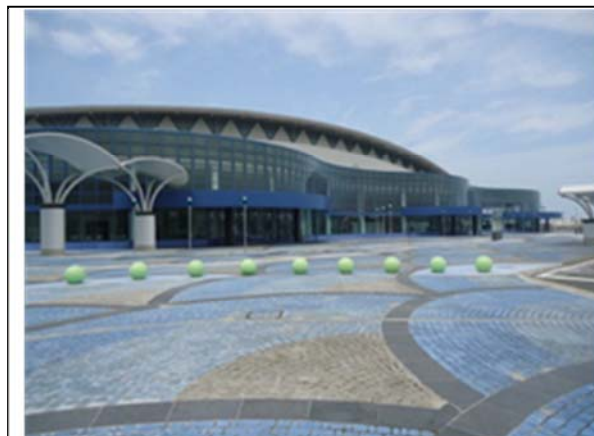
平成 24 年 6 月 29 日 復旧工事完了
