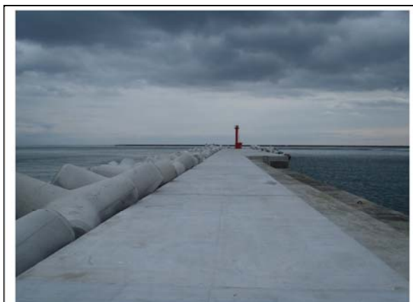
平成24年12月20日日本復旧完了
