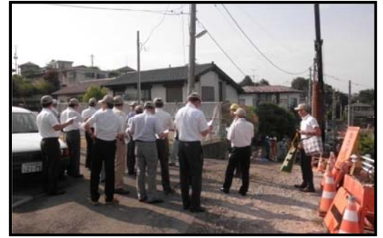
緑ヶ丘地すべり災害復旧工事現場視察
