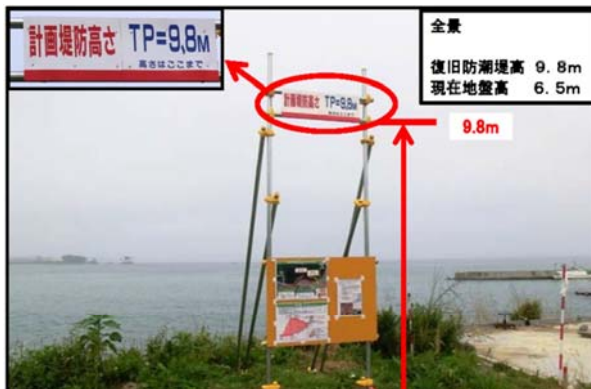
復旧高さ標示様子
