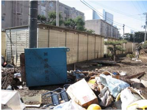
県営多賀城八幡住宅団地 団地被災状況
