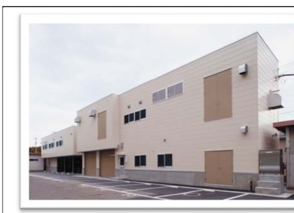
平成 24 年 10 月 31 日 復旧工事完了 新築機械室棟（2階に主要電気設備を設置）
