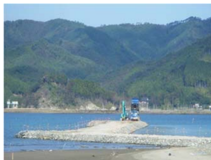
水没している沿岸地域での工事 (横須賀海岸復旧工事)
