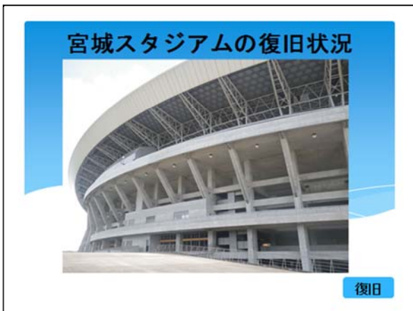
平成 24 年 7 月 13 日 復旧工事完了
