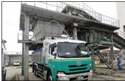
▲脱水ケーキ搬出状況
