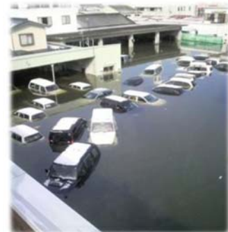
津波で浸水した東部土木事務所
