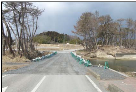
災害復旧応急工事完了後
