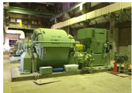
送風機設備復旧完了
