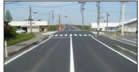
▲石巻鹿島台大衡線二郷外道路
