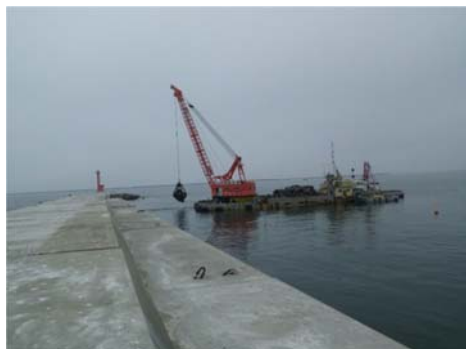
▲新北防波堤被覆石撤去
