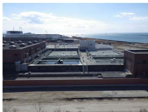
平成24年9月18日 1系水処理再開・復旧完了 平成24年12月25日 3系水処理再開・復旧完了
