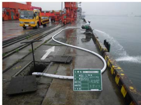
▲給水管の洗浄状況
