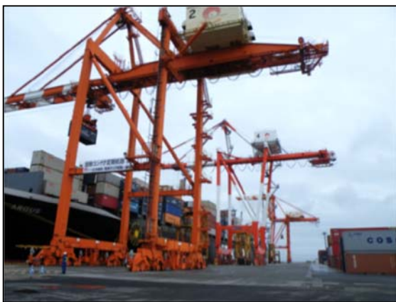
復旧した高砂CYとGC〔仙台塩釜港(仙台港区)〕
