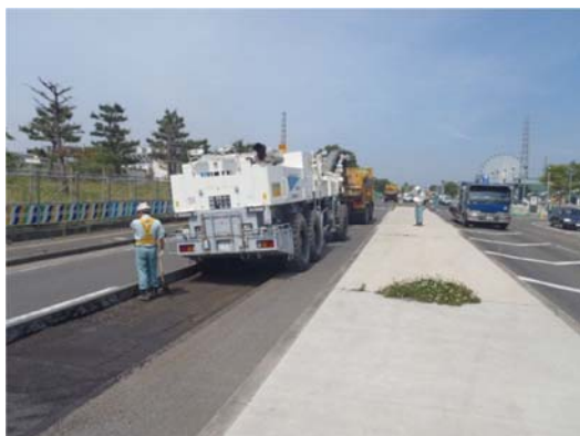
▲ふ頭5号線路面切削状況
