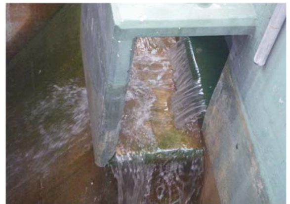
最初沈殿池 通水開始状況
