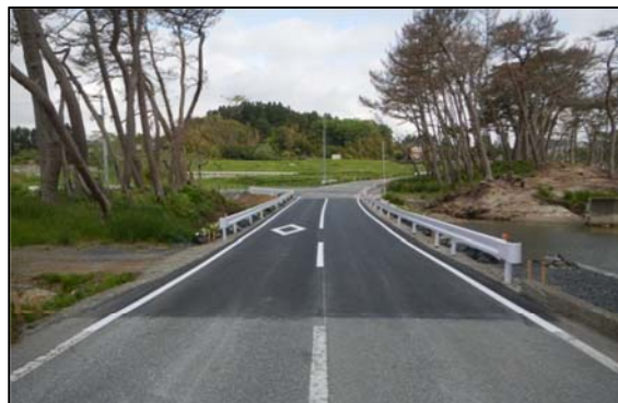
仮舗装工事完了後
