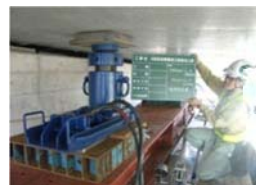
▲鉛直用 200ton ジャッキ
