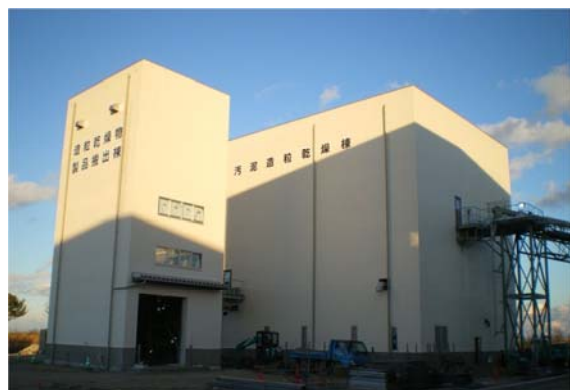
平成25年2月復旧完了
