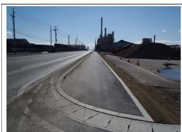
平成25年3月 本復旧完了
