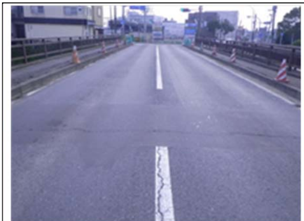
▲平成 24 年 5 月 23 日 復旧完了
