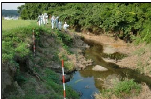
災害査定状況
