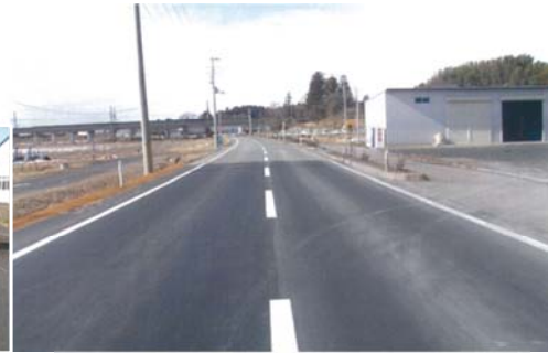
▲有賀道路災害(一)油島栗駒線)復旧後
