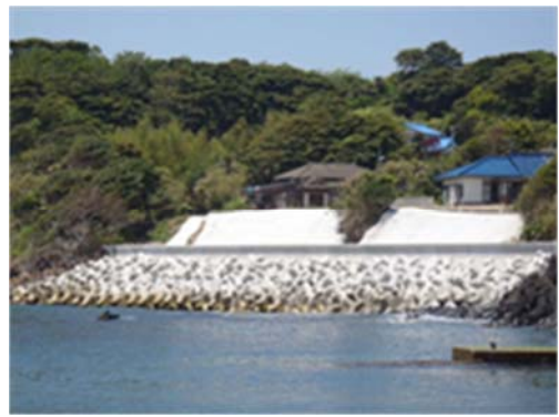
平成24年5月19日 応急復旧完了
