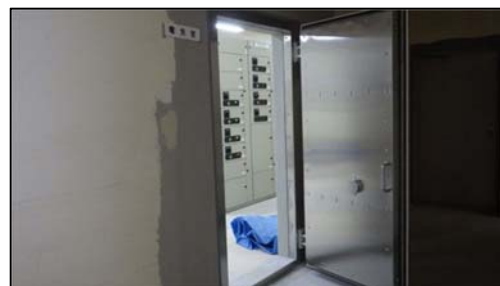
▲復旧状況（石巻第6ポンプ場：防水扉の設置）
