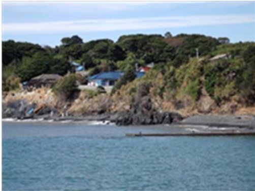
長渡海岸応急工事(その1) 被災状況
