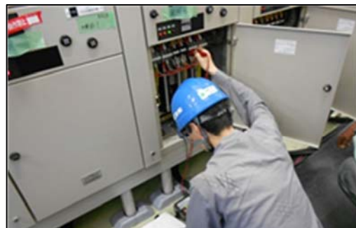
▲汚泥処理試運転状況
