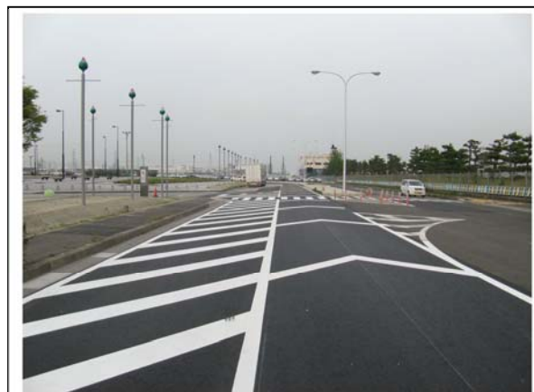
▲平成24年7月19日日本復旧完了
