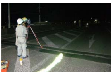
▲道路法線の確認
