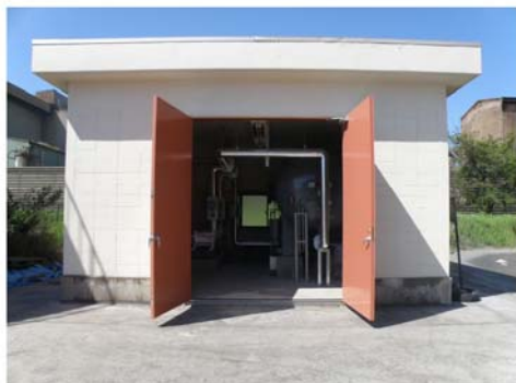
▲給水タンク復旧
