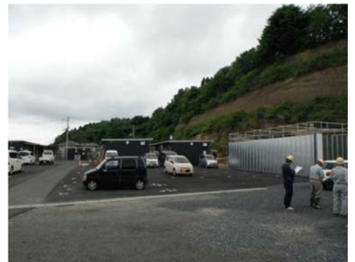
▲土砂災害危険箇所等の点検パトロール
