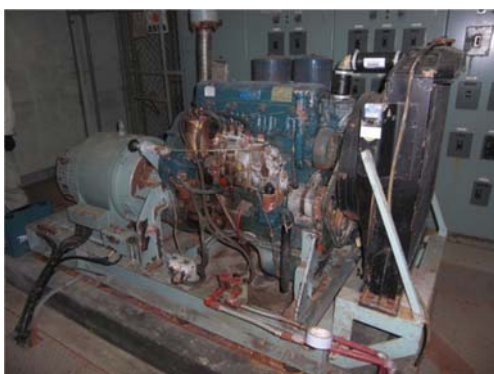
地下1階で冠水した非常用発電機
