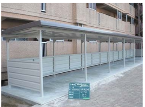
▲平成24年12月20日 本復旧完了
