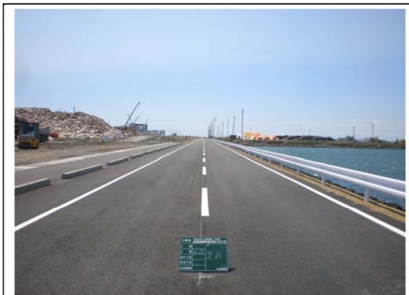
平成24年5月11日 本復旧完了
