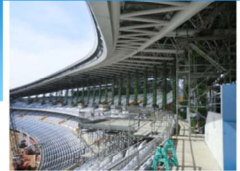
仮設柱設置完了
