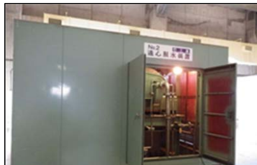
▲汚泥処理試運転状況
