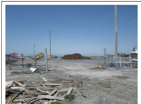
雲雀野中央埠頭荷捌地 損壊状況
