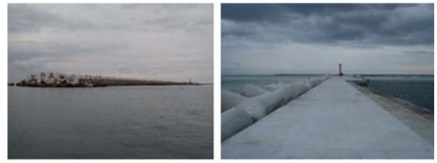
仙台港区新北防波堤 完成状況
