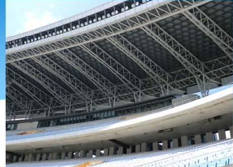
屋根T型梁の補強部材取付完了
