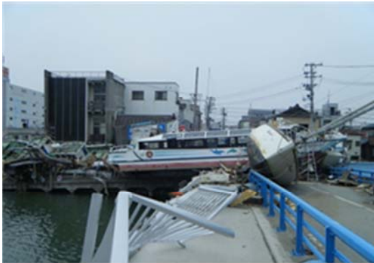
▲国道398号 石巻市中央 西内海橋 被災状況
