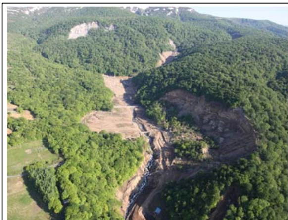
▲裏沢川 栗原市栗駒沼倉耕英東地内 平成20年岩手・宮城内陸地震による土砂災害発生状況
