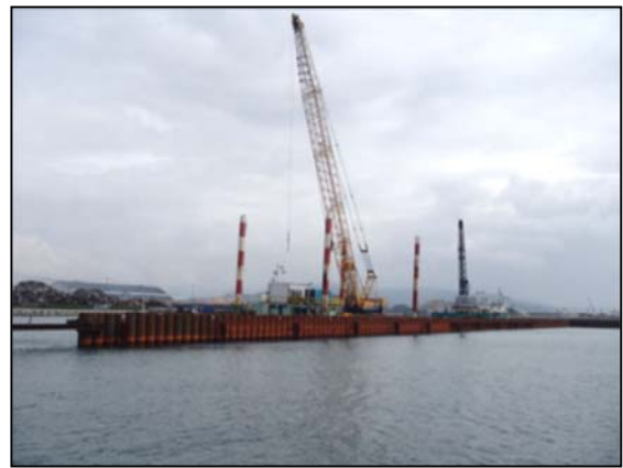
整備の進む雲雀野廃棄物埋立護岸〔仙台塩釜港(石巻港区)〕
