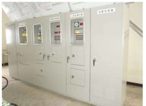
▲機側盤の更新工事完成
