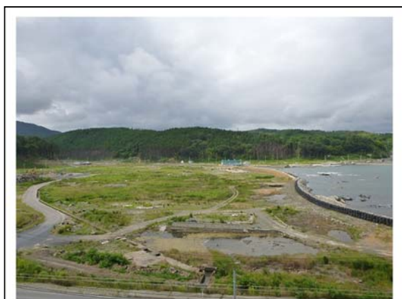
戸倉地区海岸 南三陸町戸倉地内 防潮堤応急復旧状況
