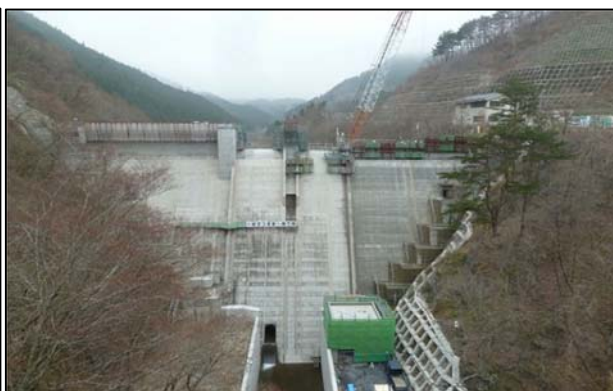
下流からのダム全景
