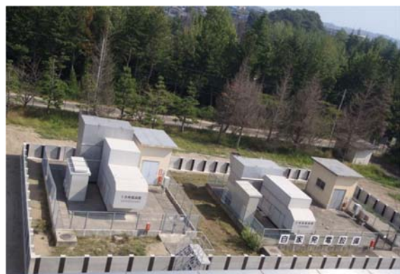
平成24年8月復旧完了 (津波浸水対策(防潮壁)も併せて実施)
