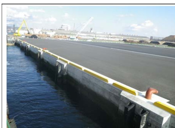
平成24年12月18日 部分復旧完了
