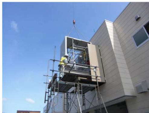
機械室棟2階に搬入する受変電設備
