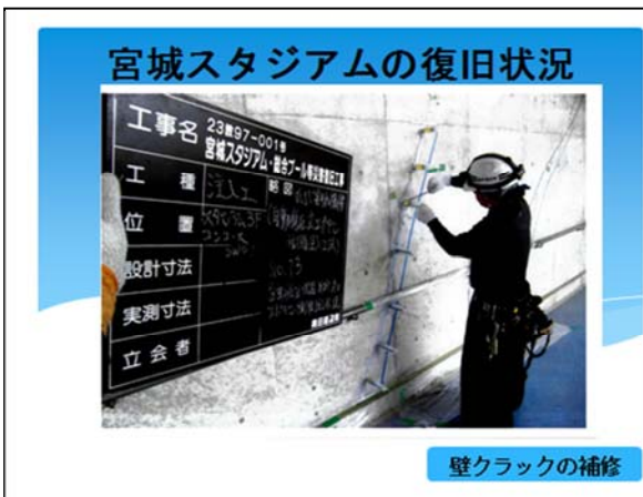
宮城スタジアム（宮城郡利府町） 改修工事中
