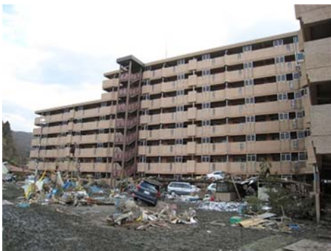
県営石巻吉野住宅団地 団地被災状況
