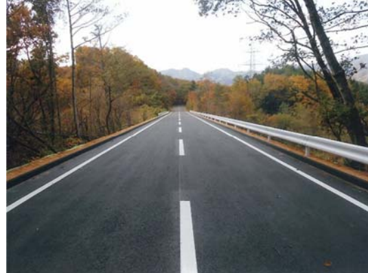
▲平成24年11月2日 本復旧完了
