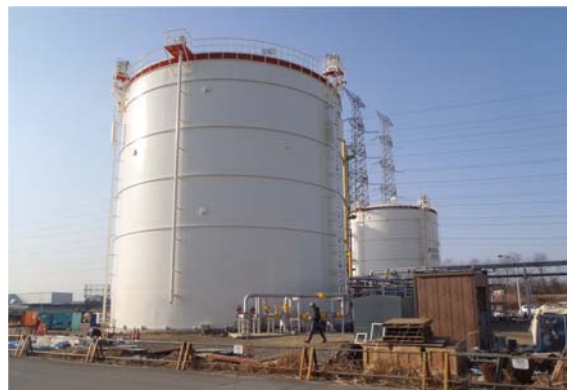
平成25年3月復旧完了
