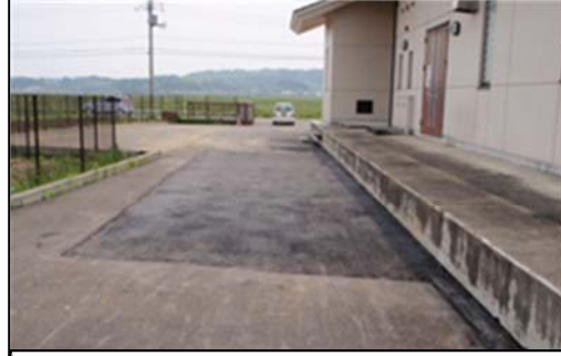
▲若柳第1ポンプ場復旧後
