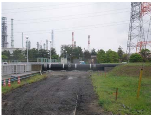
バイパス管接続状況
