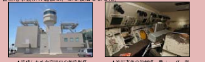
▲完成した仙台空港内の新管制塔 ▲被災直後の管制塔一階 レーダー室 (以上、国土交通省 東部航空局 仙台空港事務所から情報提供です。ご提供ありがとうございます。)
