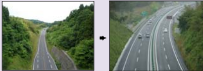
▲4車線化前 ▲4車線化後
