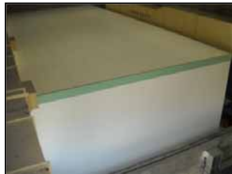
<新たに2Fに設置された電気室>
