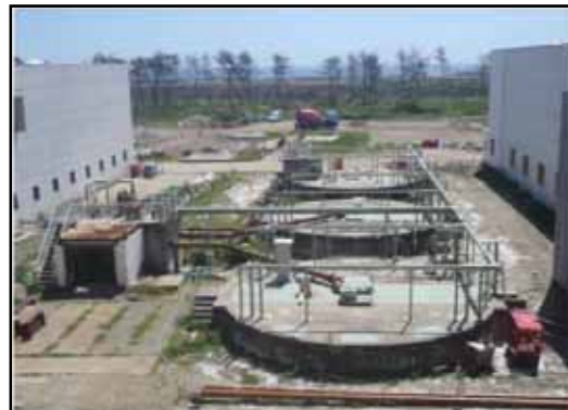
<重力濃縮設備の復旧状況>
