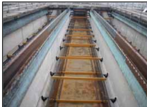
<第3系列 最終沈殿池復旧状況>
