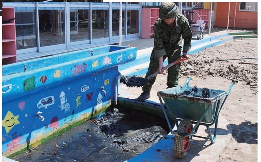
「東保育所の手洗い場にたまったヘドロを手作業で取り除き、一輪車で運搬」
