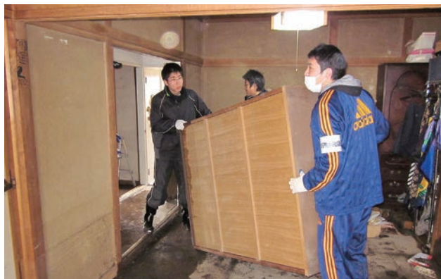
災害ボランティアセンターによる片付け作業
