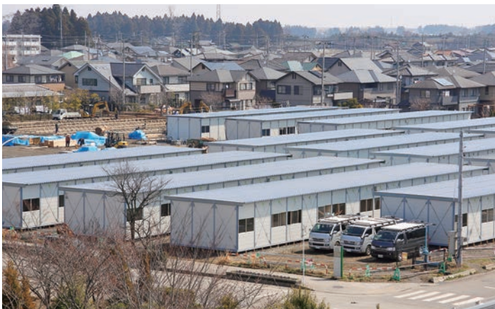
建設が進む仮設住宅
