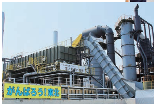
完成した焼却炉
