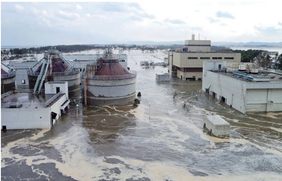
2011.3.11 16時01分 「県南浄化センター」 提供：宮城県
