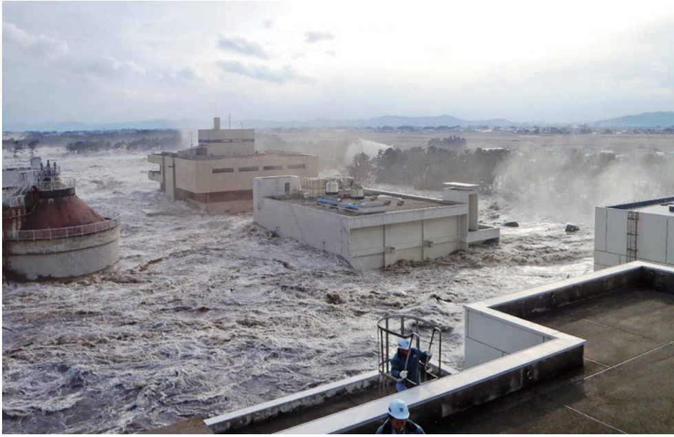
2011.3.11 15時54分 「県南浄化センター」 提供：宮城県
