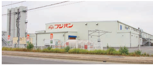
東北フジパン竣工
