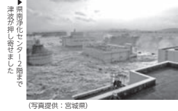
▲栗南浄化センター2階まで津波が押し寄せました (写真提供：宮城県)
