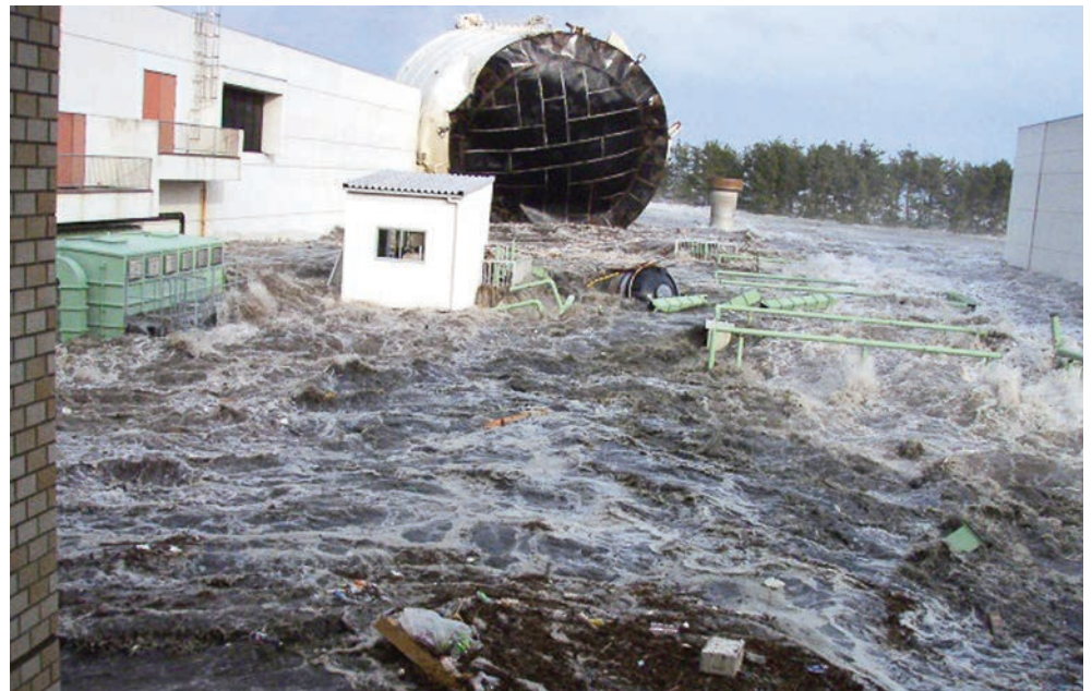
2011.3.11 15時56分 「県南浄化センター」 提供：宮城県
