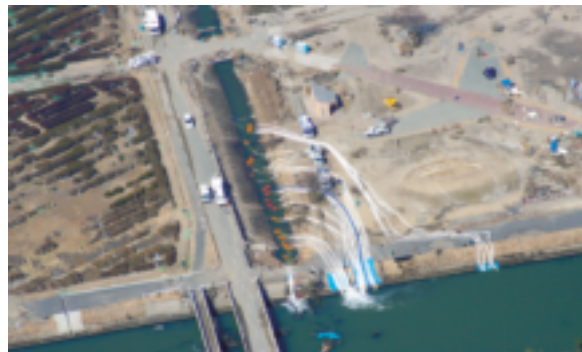
排水ポンプ車による仙台空港の排水作業（東北地方整備局）
