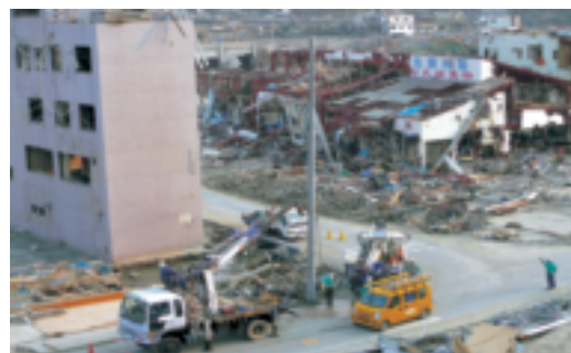
女川町における停電復旧の様子（東北電力）
