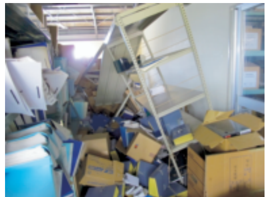
大衡村役場内の被災状況（大衡村）
