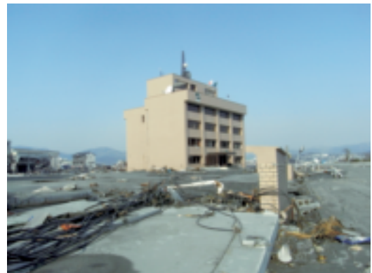
被災した気仙沼合同庁舎
