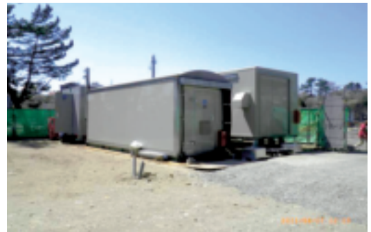
仮設 BOX の設置 (NTT 東日本)
