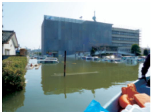
津波により水没した石巻合同庁舎
