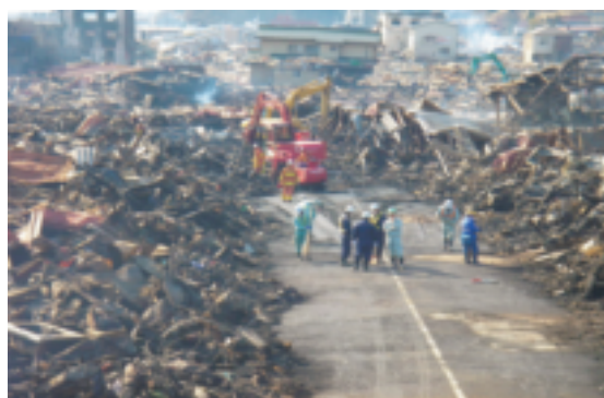
気仙沼市における道路啓開の様子（東北地方整備局）
