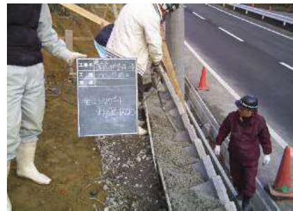
ブロック積みの施工
