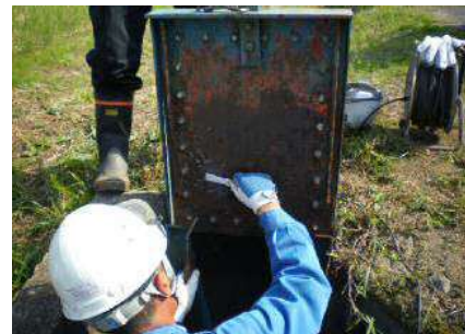
ゲートの補修状況
