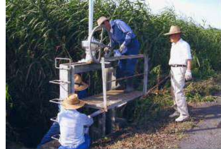
ゲートの点検
