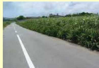
グリーンベルト設置
