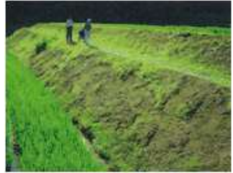
小段（犬走り）設置後の法面
