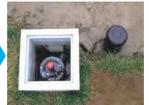
給水栓の自動化へ改良
