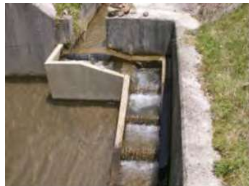
段差解消水路
