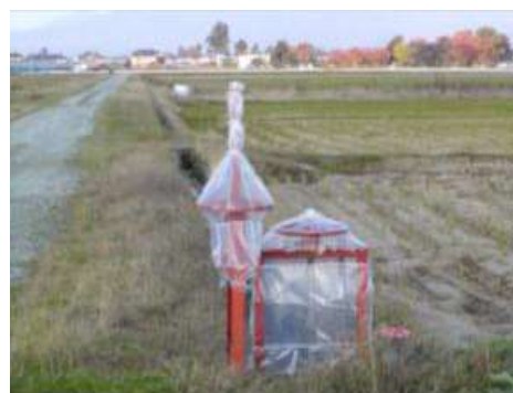
ゲートの被覆状況
