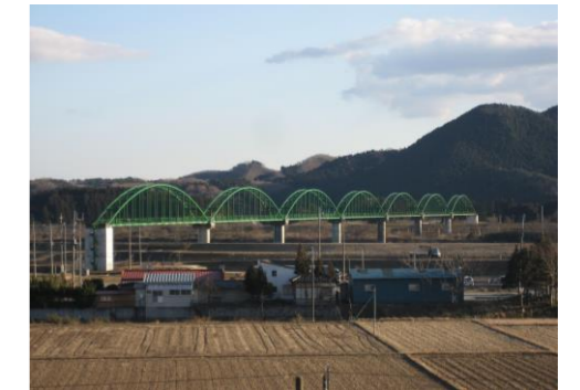
< 阿武隈川水管橋 >
