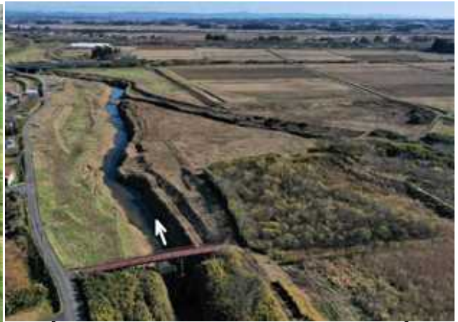
二迫川 防等橋付近 撤去後
