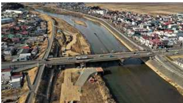
仮橋施工中(下流側)
