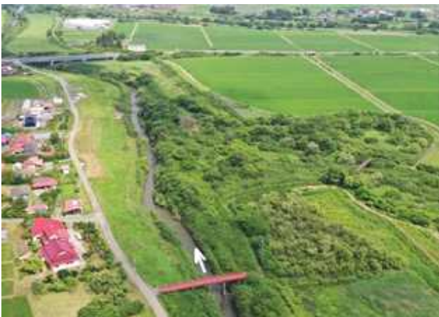
二迫川 防等橋付近 撤去前
