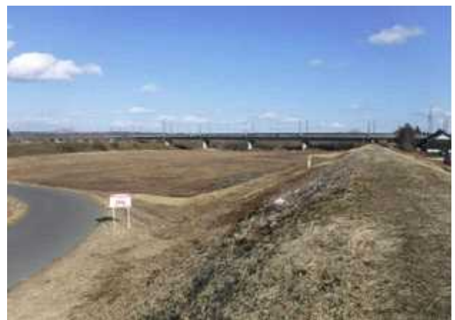
迫川 徳富橋付近 撤去後
