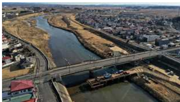
仮橋施工中(上流側)
