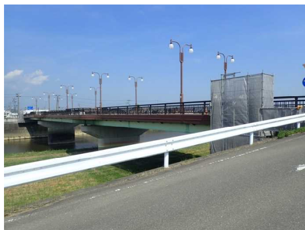
若柳大橋全景
