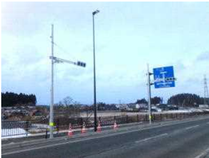
信号機の設置状況
