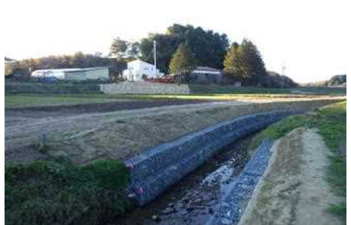
瀬峰川 復旧完了
