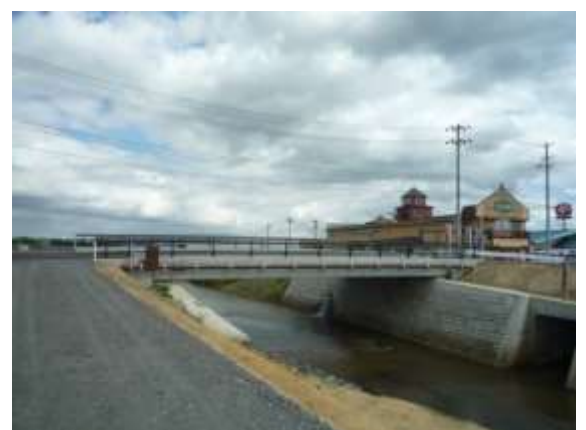
工事完了（上流側より下流側を望む）
