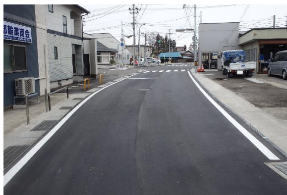
交差点改良工事の完了 (大鳥沢辺線側から鶯沢方面を望む)
