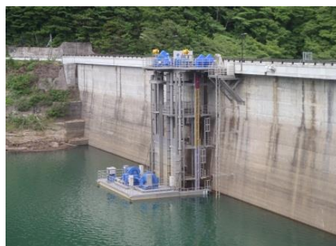
改修後の取水設備
