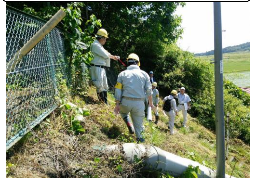
急傾斜地 寺前地区
