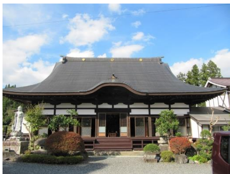
洞泉院の外観
