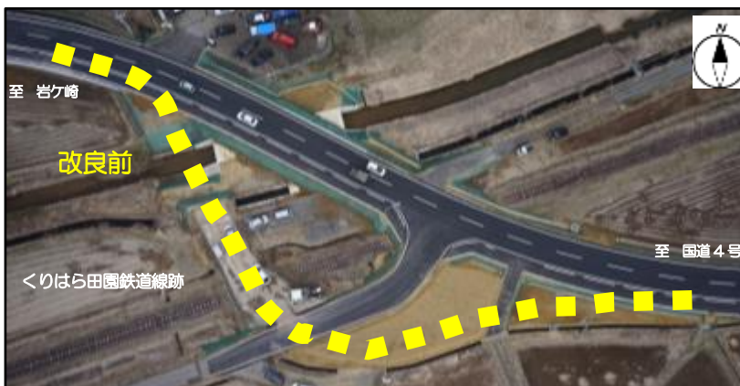
急カーブ解消箇所
