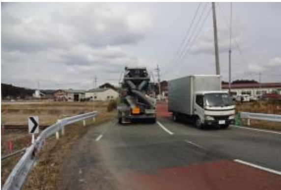
改良前の道路
