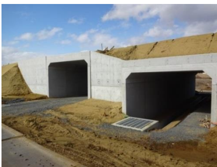
函渠の設置状況①
