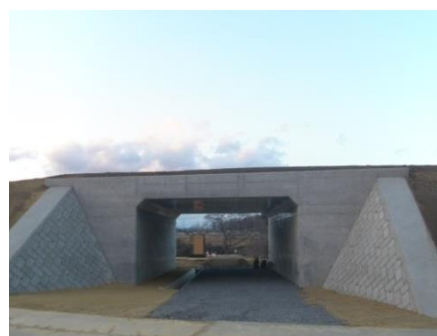
函渠の設置状況②
