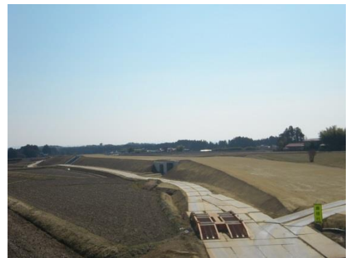
盛土工事の状況
