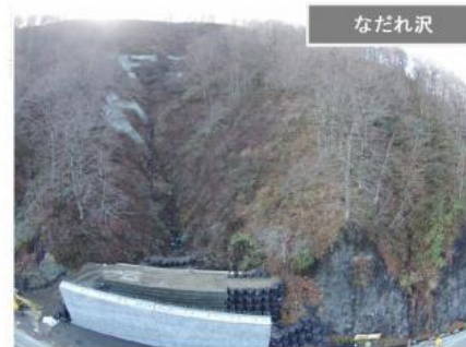
スノーシェッド下部工（手前）と雪崩防護擁壁（奥）
