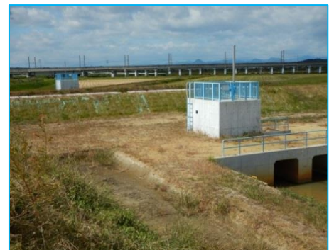
完成 (地上に見えるのは排水路の吞吐口のみ)
