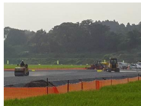
②工事位置の様子
