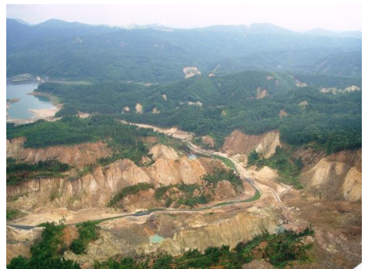
平成 20 年岩手・宮城内陸地震による被災箇所
