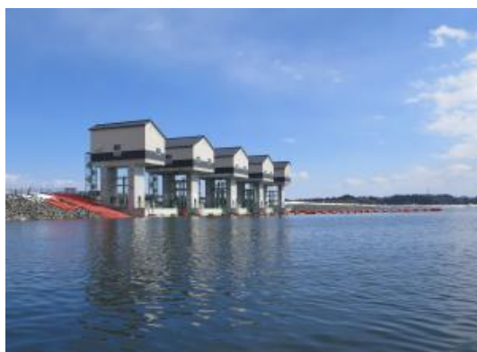
長沼ダムの水門
