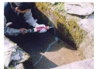
水路のひび割れ補修
