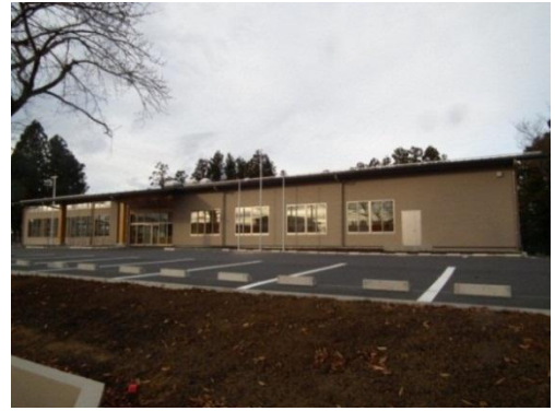
栗原市産木材で建築された栗原市高清水総合支所
