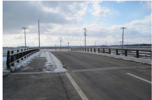
架替工事が完了した「新田橋」
