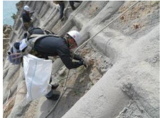
【設置作業の状況】
