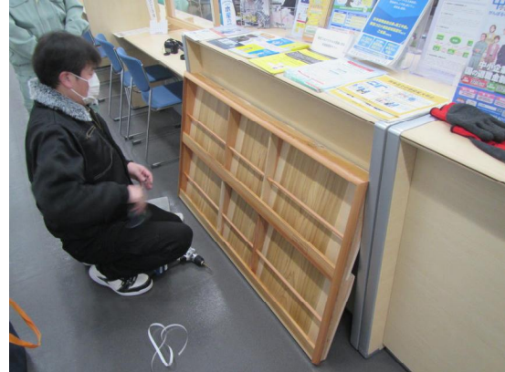
【設置作業の様子】
