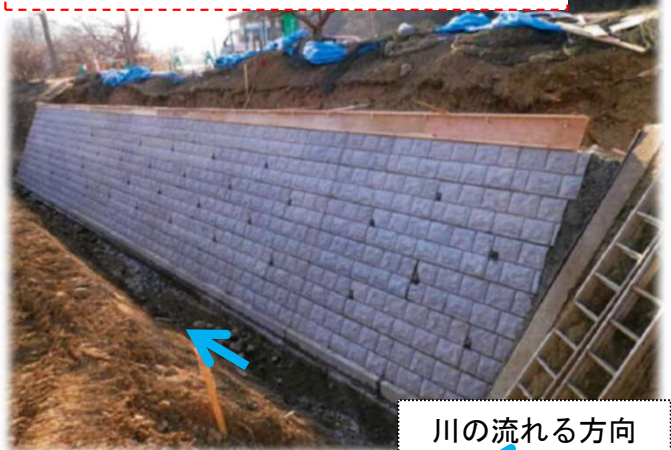
⑩ 伊手川 100号(2工区) 実施状況
