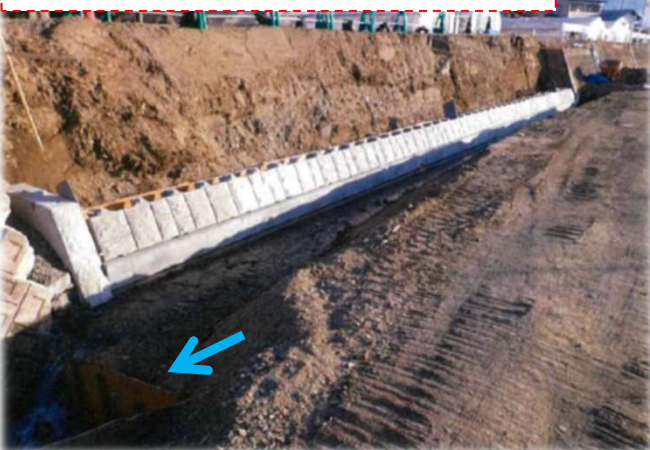
⑩ 伊手川 97号(2工区) 実施状況
