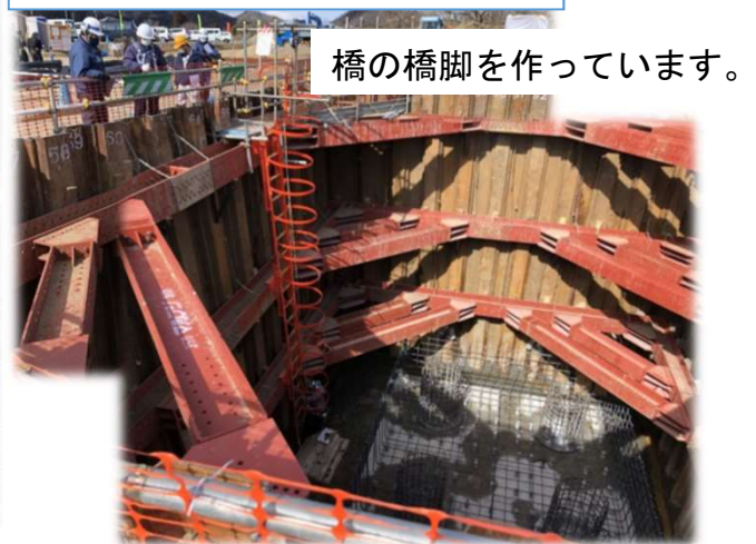
④ 中平橋 (下部工) 実施状況
