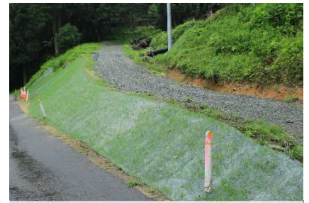
法面植生状況
