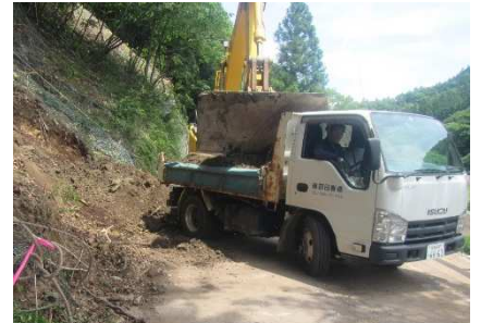
金網・崩土運搬
