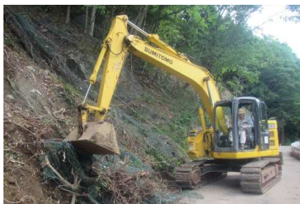
金網・崩土撤去
