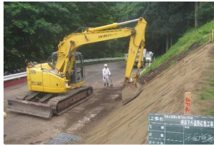
法面整形作業
