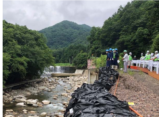
災害復旧現場説明状況
