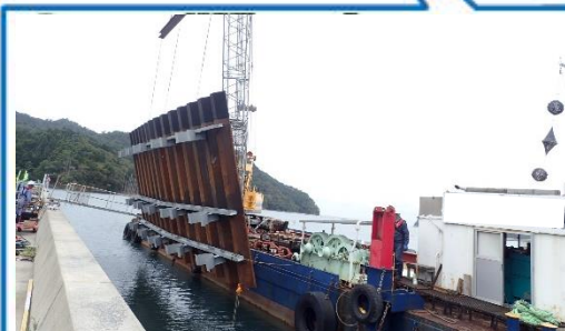
【カーテンウォール設置状況】
