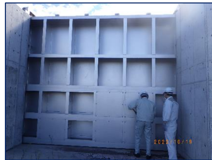
陸閘点検状況
