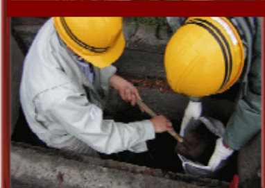
側溝を事務所職員が清掃
