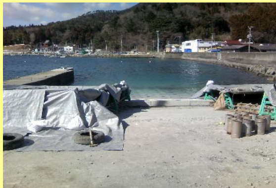
船揚場改良工事状況
