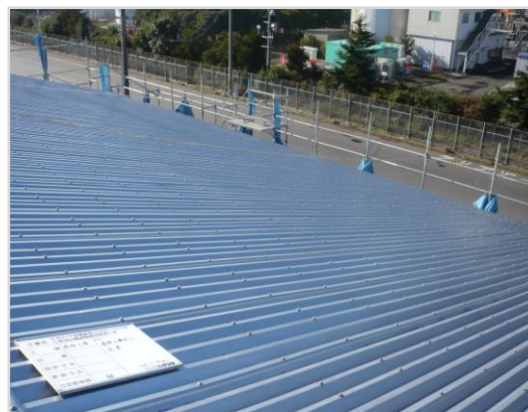
中島上屋施工後
