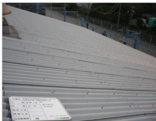
中島上屋施工前
