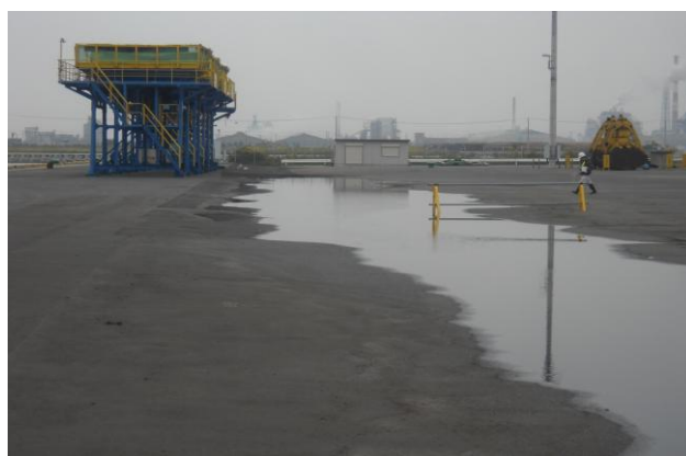
<施工箇所：2号荷捌地>
