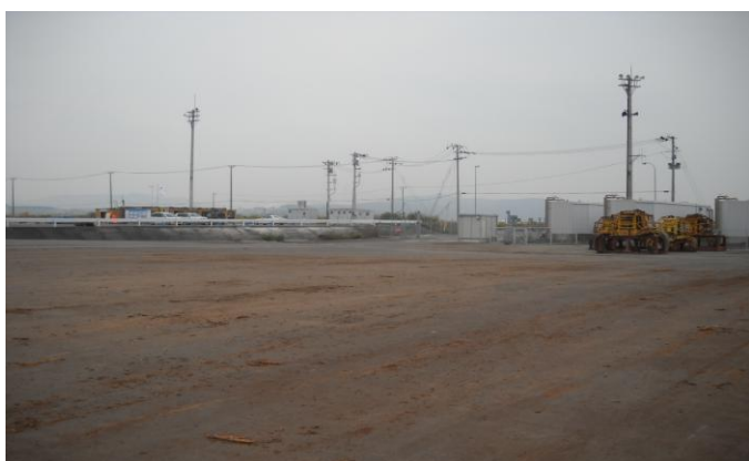
<施工箇所：中央ゲート付近>
