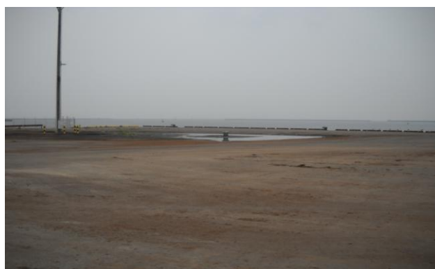
<施工箇所：1号荷捌地>
