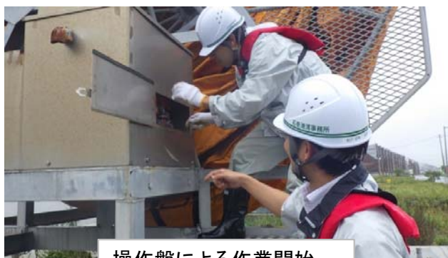
操作盤による作業開始
