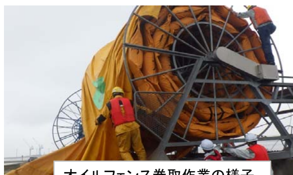
オイルフェンス巻取作業の様子
