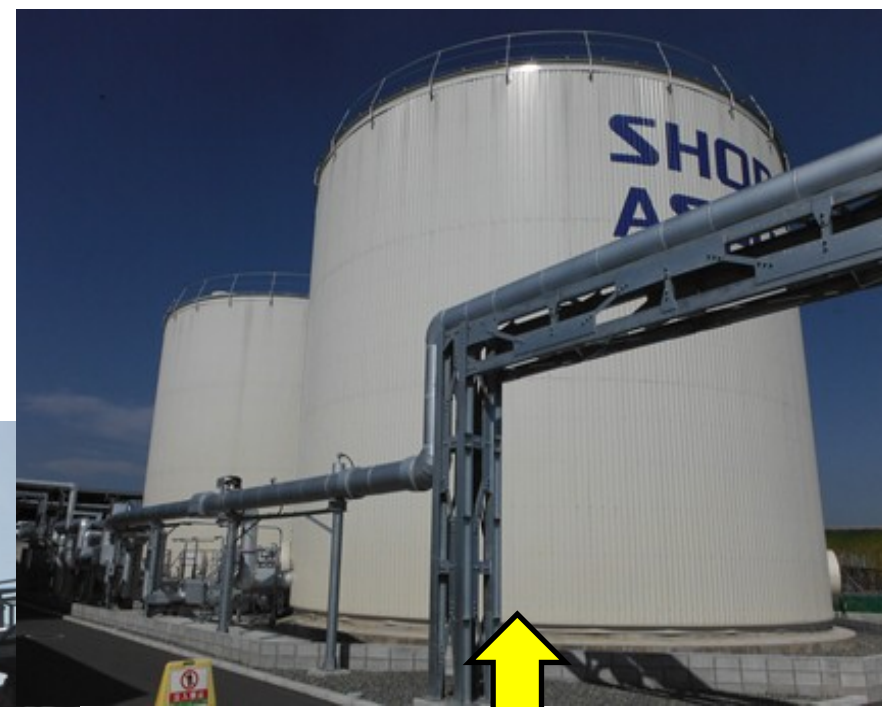
:ストレートアスファルト貯蔵タンク
