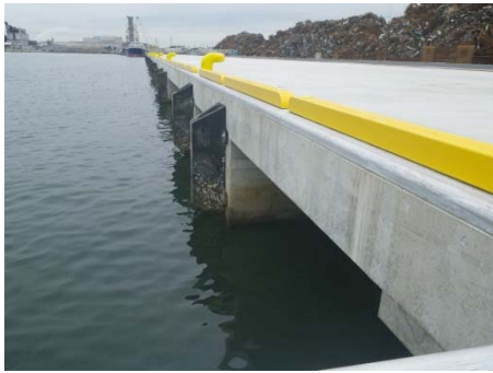
①大手 1 号岸壁
