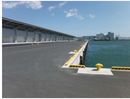
②大手 5 号岸壁
