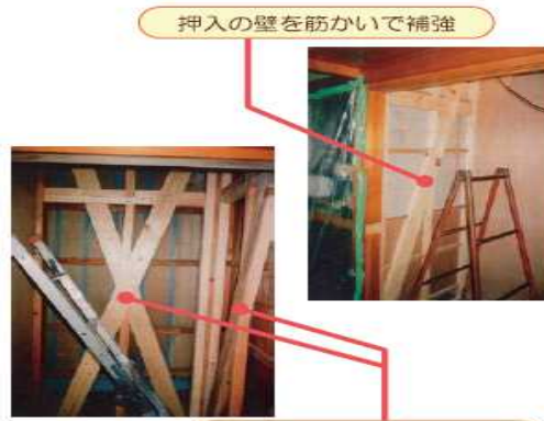
物入の壁を筋かいで補強
