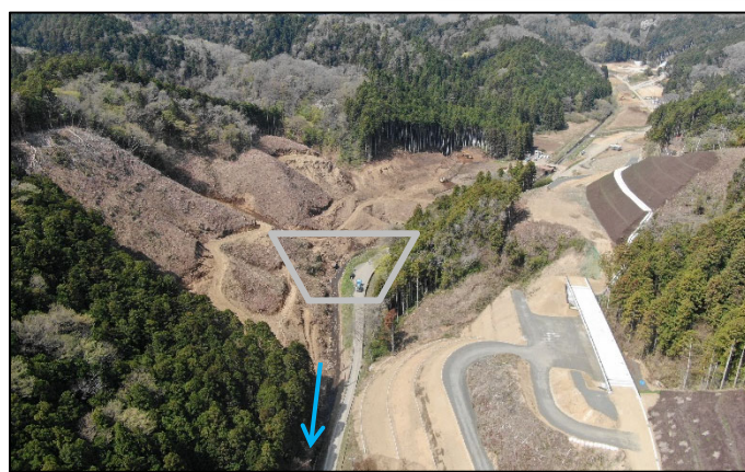
ダム建設位置
