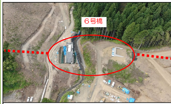
①(R3)6号橋下部工事
