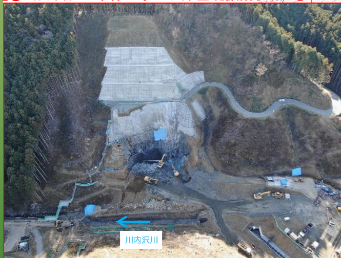
【①川内沢ダム本体工事 右岸基礎掘削状況！】
